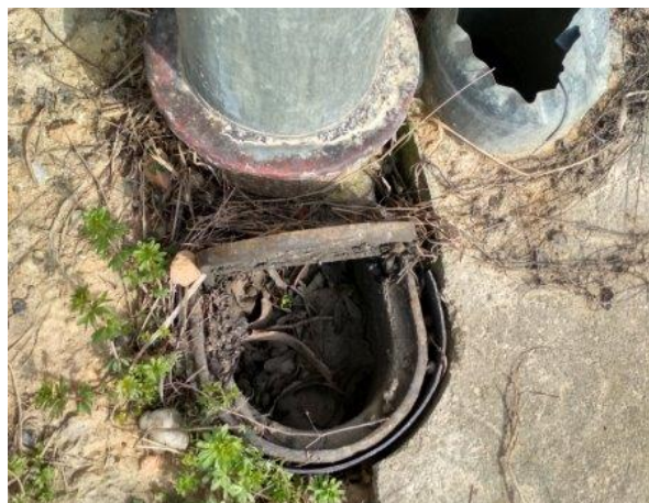
obr. /43/ Lapač střešních naplavenin je plný nečistot a je snížena jeho účinnost
