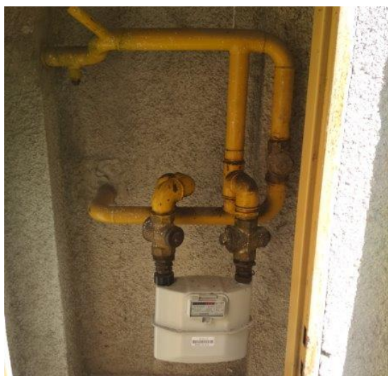
obr. /44/ Hlavní uzávěr plynu v místě hlavního vstupu do objektu bývalé školy
