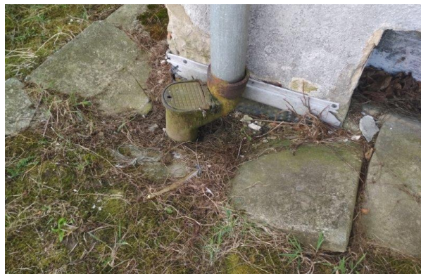
obr. /17/ Okapový chodníček se místy propadá
