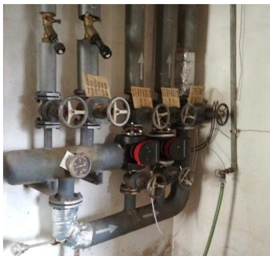
obr. /38/ Původní rozvody výměníku
