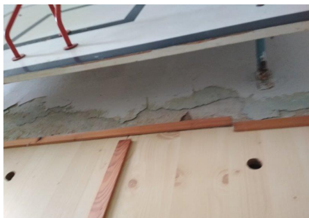
obr. /6/ V tělocvičně opadává vnitřní omítka
