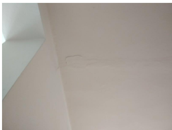
obr. /7/ Trhliny ve stropních konstrukcích objektu jsou spíše ojedinělé
