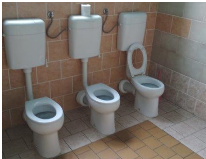
obr. /33/ Pohled na WC s nástěnnou splachovací nádržkou
