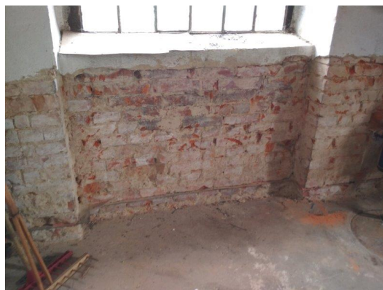
obr. /4/ Vnitřní omítky suterénu jsou oklepaný
