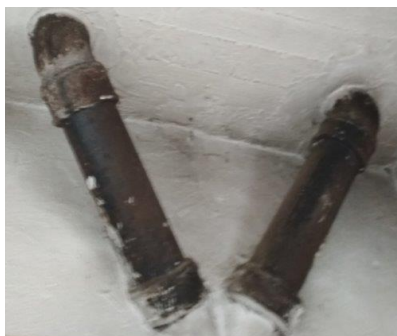
obr. /29/ Původní litinové potrubí
