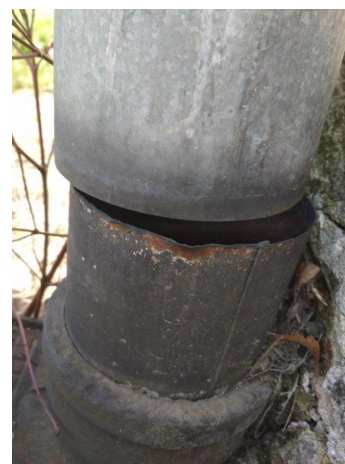
obr. /28/ Napojení dvou dílců dešťového svodu vykazuje netěsnosti
