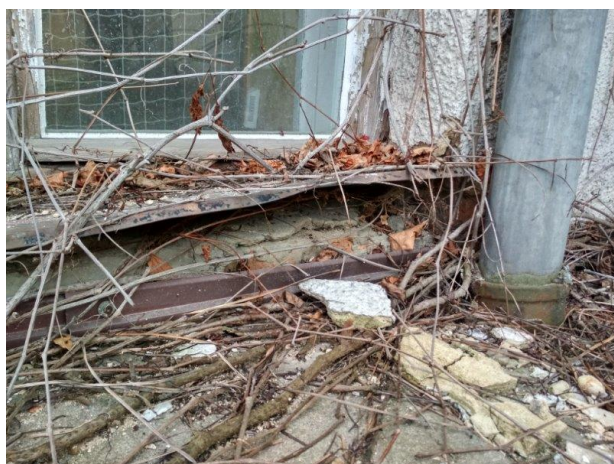
obr. /27/ Deformace okenního parapetu
