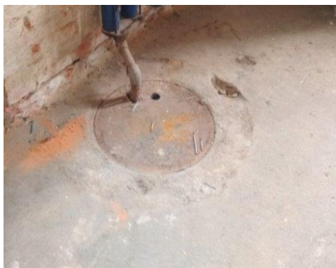
obr. /14/ Podlaha výměníku je tvořená betonovou mazaninou, která je místy poškozená
