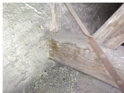
obr. /26/ Doporučujeme prověřit stav zazděných zhlaví vazných trámů
