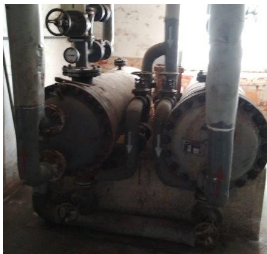
obr. /39/ Původní výměníková stanice s tlakoměrem
