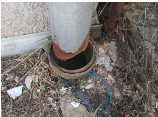
obr. /42/ Dešťový svod v místě upraveného terénu je značně zdegradovaný a může docházet k výtoku srážkové vody na terén
