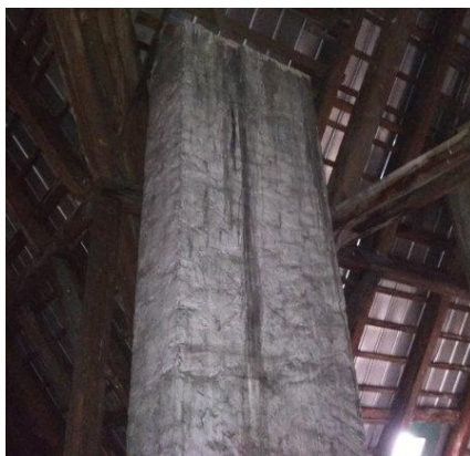
obr. /20/ V prostoru nevytápěné půdy je komínové těleso omítnuto. Na omítce se nacházejí stopy lokálního zatečení.
