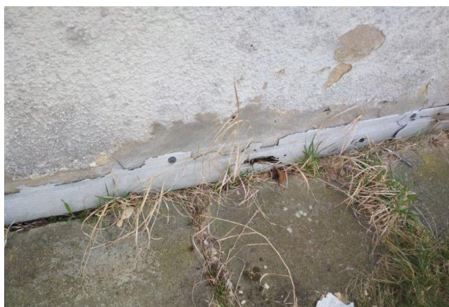
obr. /23/ Vytažení nopové fólie bez krycí lišty
