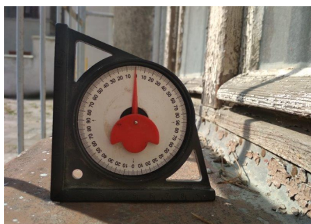
obr. /25/ Nedostatečný sklon okenních parapetů
