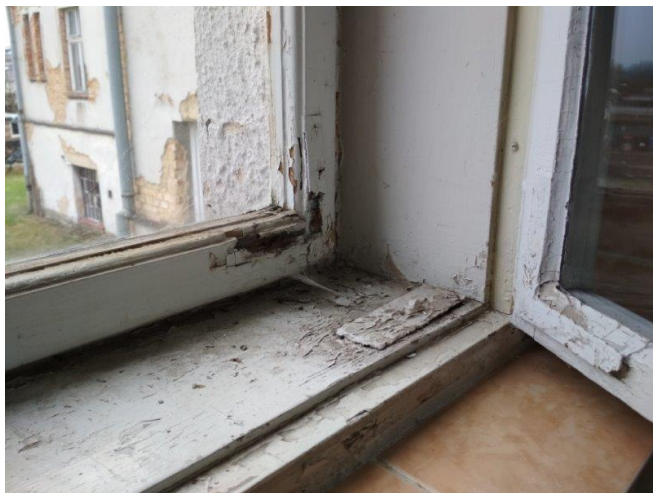
obr. /12/ Původní okenní výplně jsou značně zdegradované
