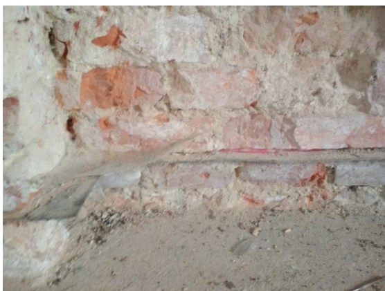
obr. /3/ Obvodové zdivo je dodatečně podřezáno a doplněno novou hydroizolační vrstvou
