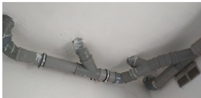
obr. /30/ Zrekonstruované potrubí z polypropylenu
