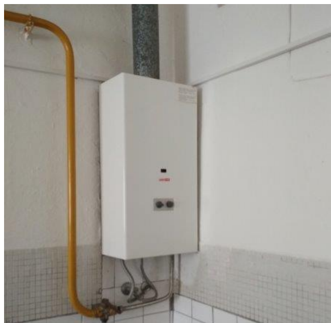
obr. /35/ Plynovod je napojen na plynový kotel
