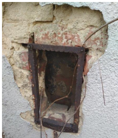
obr. /19/ Chybí dvířka vybíracího otvoru
