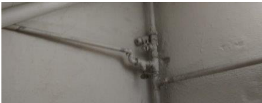
obr. /31/ Původní vodovodní potrubí a armatury jsou pravděpodobně na hranici své životnosti
