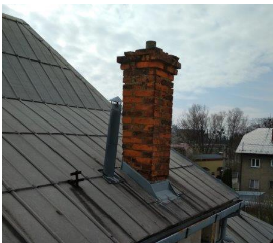
obr. /18/ Pohled na komínový plášť vyzděný z plných cihel
