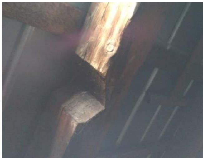
obr. /9/ Krokev je oslabena výřezem
