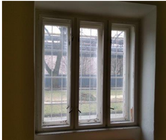
obr. /13/ Pohled na původní kastlová okna ze strany interiéru objektu
