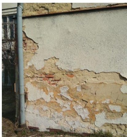
obr. /5/ Z vnější strany fasády opadává omítka
