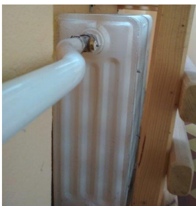
obr. /40/ Ocelové článkové otopné těleso
