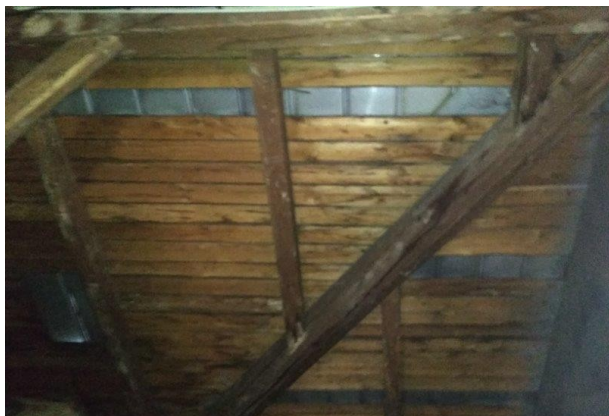
obr. /24/ V některých místech chybí prvky dřevěného bednění
