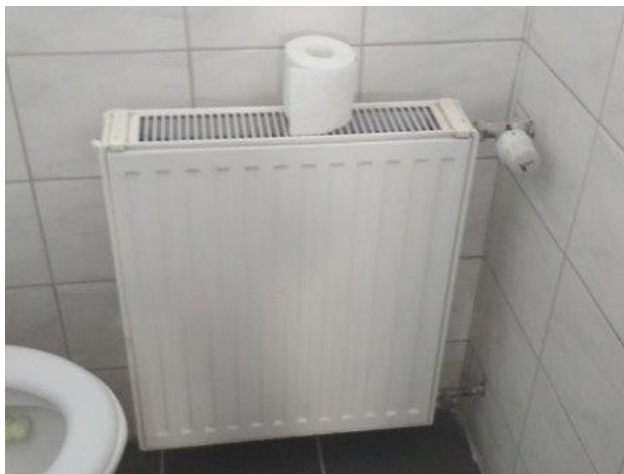
obr. /32/ Dvojitý deskový ocelový radiátor
