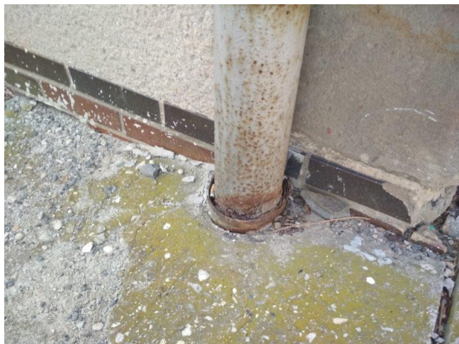
obr. /36/ V místě upraveného terénu není dešťový svod doplněn lapačem střešních splavenin
