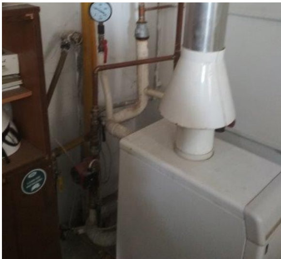
obr. /34/ Zdrojem vytápění je plynový kotel v 1.NP obr. /35/ Červená membránovou expanzní nádoba
