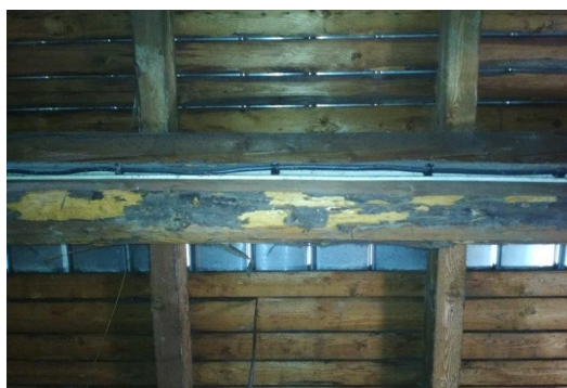
obr. /11/ Střešní konstrukce je vynášena krovem, který je pravděpodobně napadený dřevokaznými škůdci
