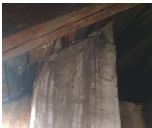
obr. /22/ Omítka komínového tělesa v podkrovním prostoru obsahuje stopy zatékání způsobené netěsností střešního pláště
