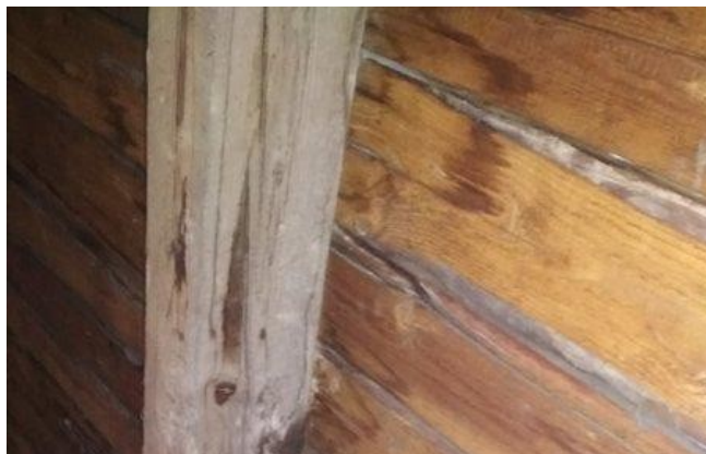
obr. /25/ Na dřevěných prvcích krovu se nacházejí stopy lokálního zatekání
