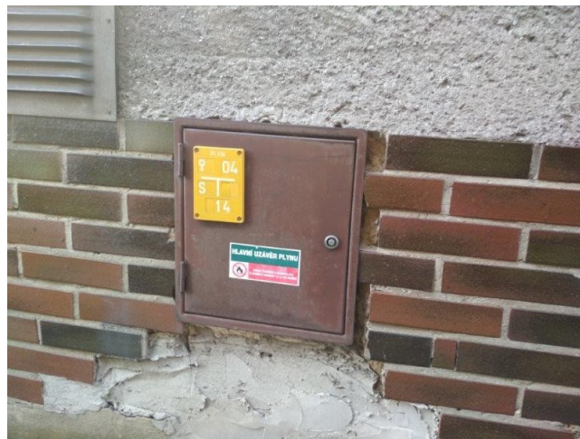
obr. /37/ Pohled na hlavní uzavěr plynu
