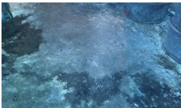
obr. /17/ Nášlapná vrstva suterénních prostorů je převážně tvořena betonovou mazaninou
