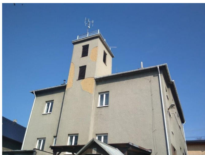
obr. /8/ Opadávání vnější omítky fasády na západní straně věže objektu
