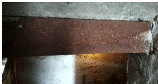
obr. /10/ Ocelový nosník vynášející schodišťové rameno je zdegradovaný a na jeho povrchu se nachází koroze
