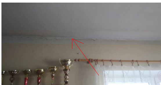
obr. /9/ Vodorovná trhlina v místě uložení stropní konstrukce
