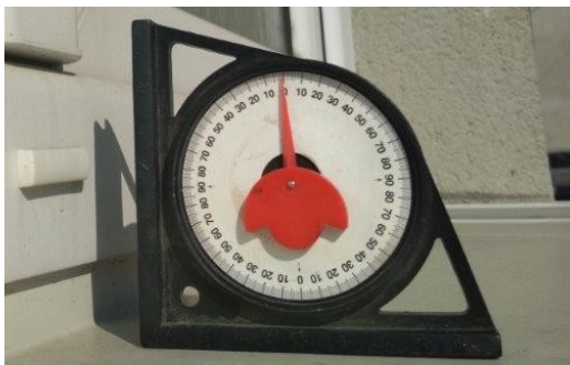
obr. /26/ Sklon některých okenních parapetů je pouze 1° směrem od objektu
