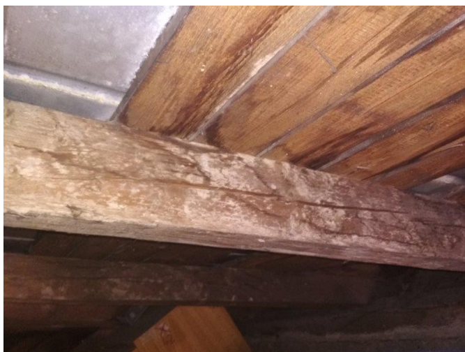
obr. /3/ Stopy zatékání na dřevěném bednění střechy
