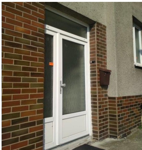
obr. /13/ Plastové vstupní dveře s izolačními dvojskly
