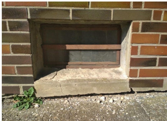
obr. /14/ Původní suterénní kovové okno
