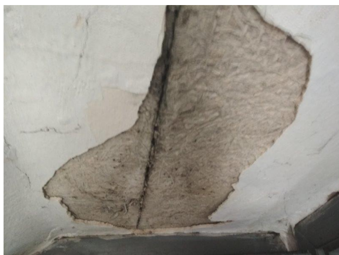
obr. /6/ Opadávání omítky a degradace podhledu nad schodišťovým prostorem z dřevovláknitých desek
