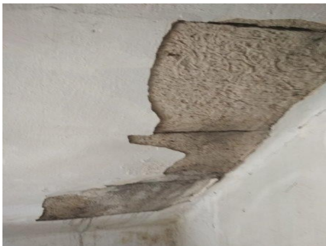
obr. /5/ Opadávání omítky a degradace podhledu nad schodišťovým prostorem z dřevovláknitých desek
