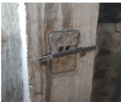
obr. /21/ Omítka komínového tělesa v podkrovním prostoru obsahuje stopy zatékání způsobené netěsností střešního pláště
