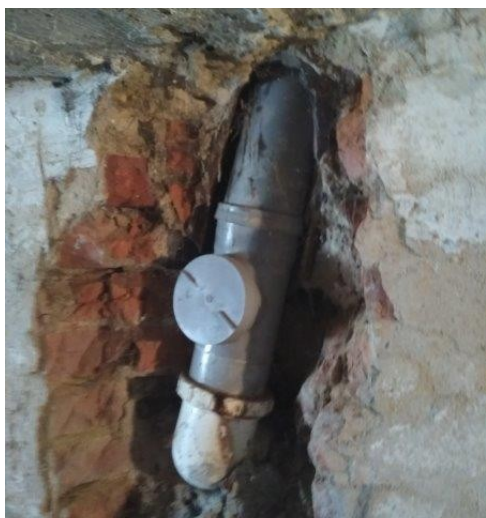
obr. /27/ Části odpadního potrubí byly zrekonstruovány za potrubí z plastu
