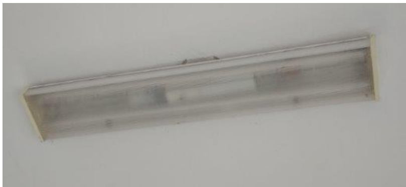
obr. /31/ Původní zářivkové osvětlovací těleso
