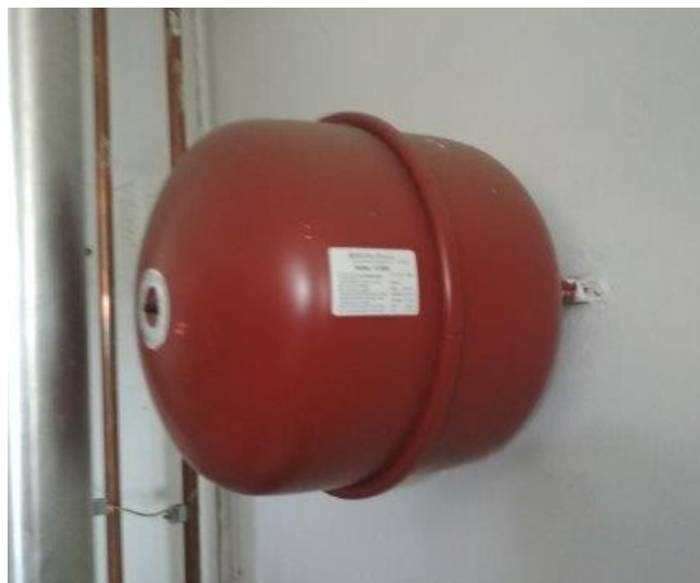
obr. /34/ Zdrojem vytápění je plynový kotel v 1.NP obr. /35/ Červená membránovou expanzní nádoba
