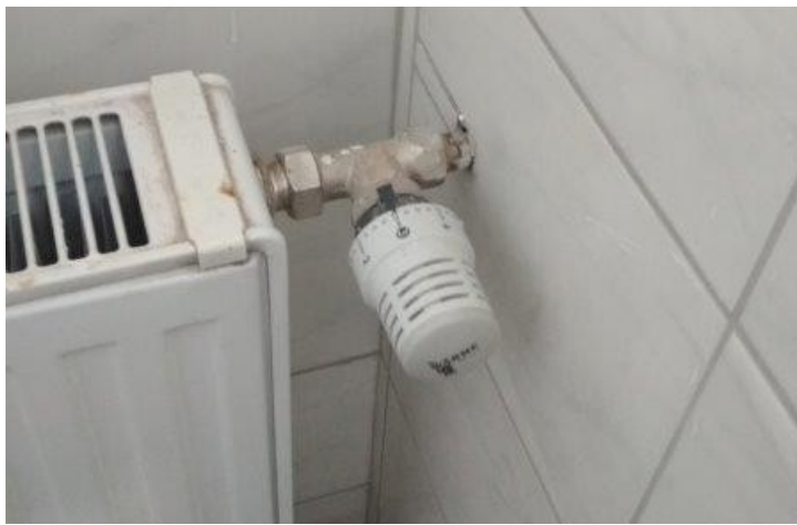
obr. /33/ Otopná tělesa jsou doplněna termostatickými hlavicemi
