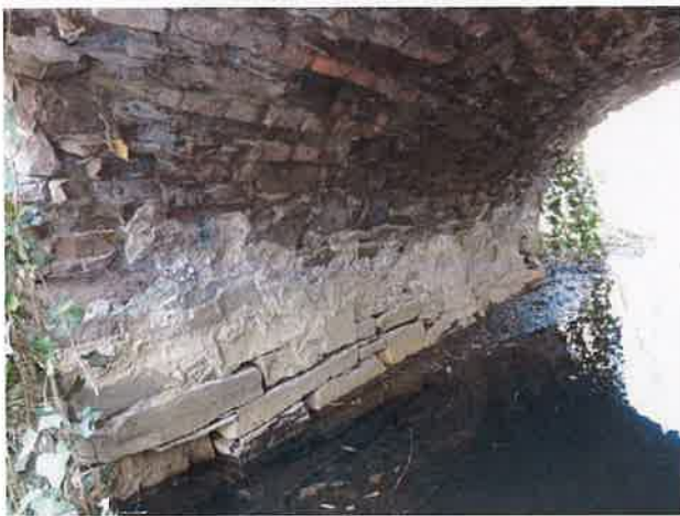
Pohled na opěru 1
