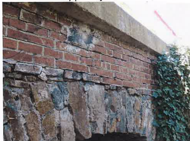
Levá čelní zeď – vysunutá nad klenbou a ve 2. a 3. řadě cihel shora
