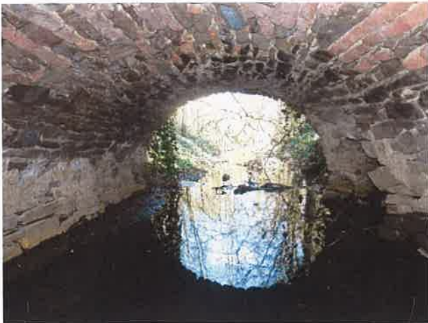
Pohled do mostního otvoru zprava (po vodě)
