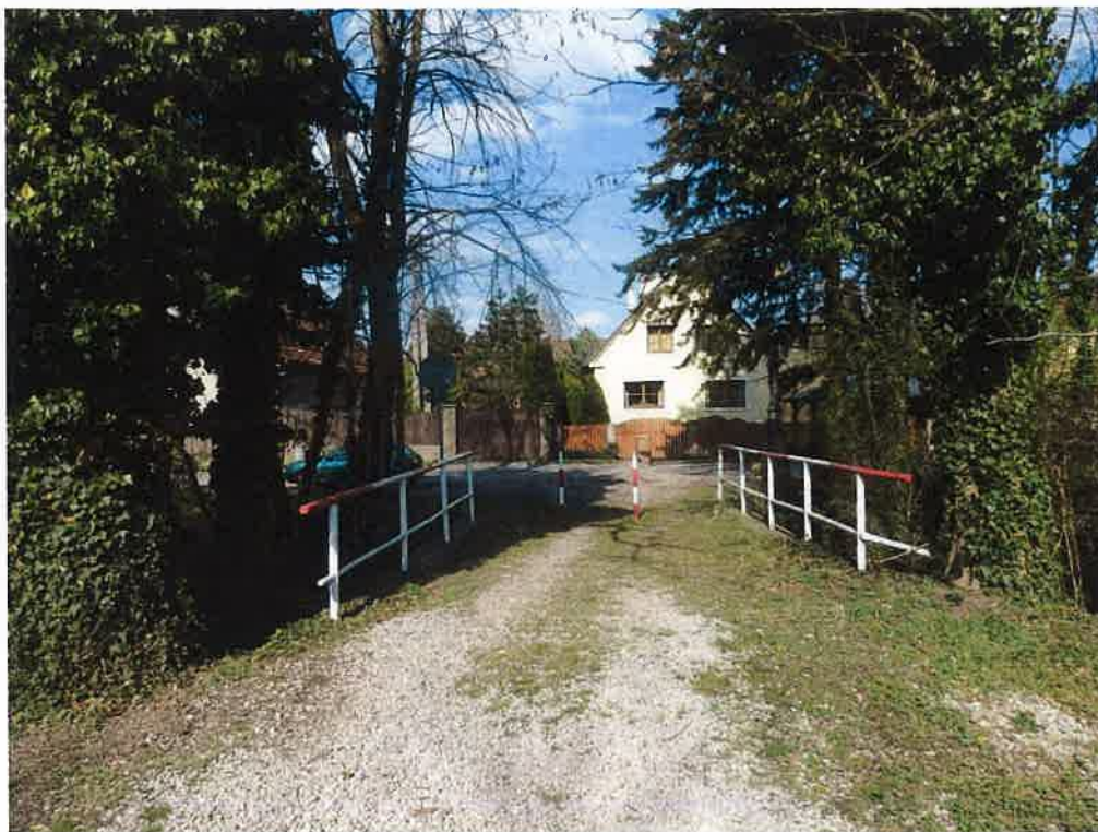
Pohled na most od ČOV k ul. Družstevní (vtok je vlevo). Na mostě jsou zábrany proti vjezdu.
