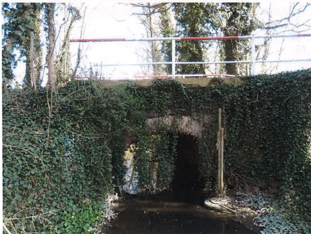
Pohled zprava (na vtok). Most je porostlý břečtanem.
