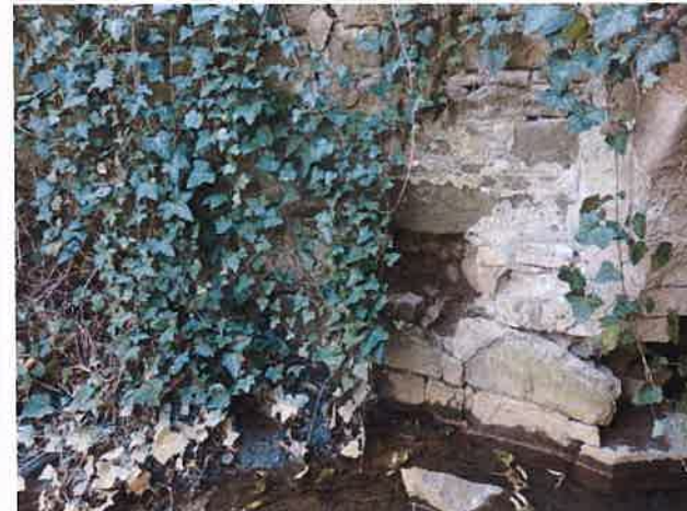
Levá čelní zeď – vysunutá nad klenbou a ve 2. a 3. řadě cihel shora
