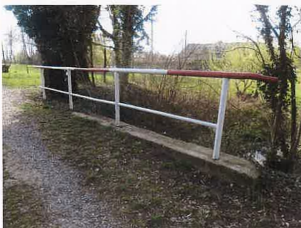
Pravá římsa a zábradlí
