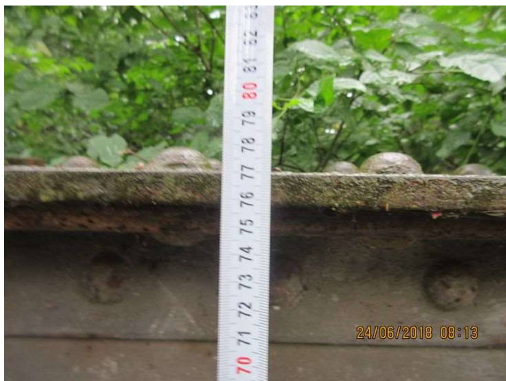
Výška zábradlí na pravé straně.
