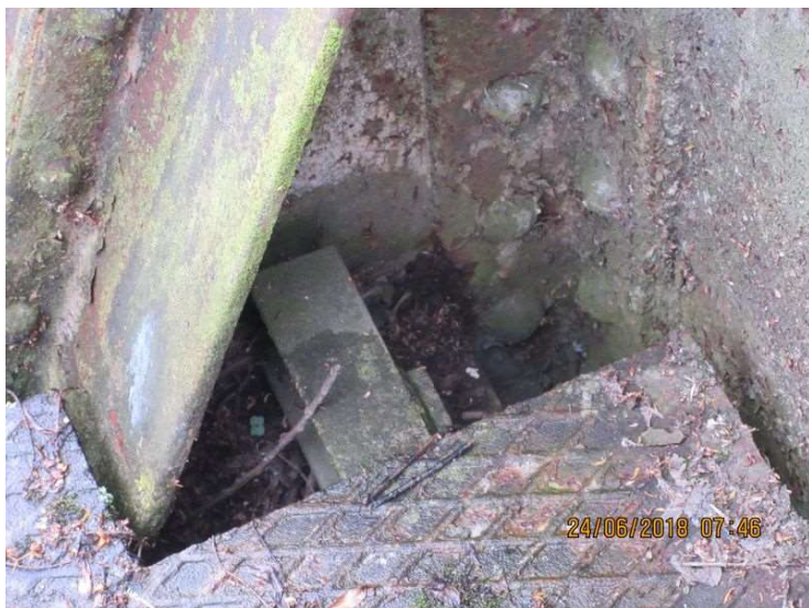
Otvory u stojin na pravém zábradlí.
