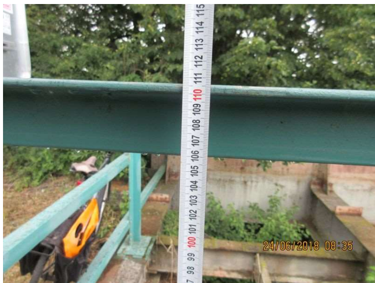
Výška zábradlí na levé straně.
