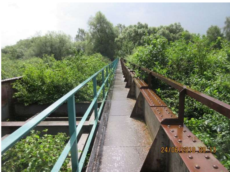
Zábradlí na mostě.
