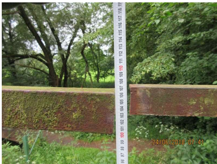
Výška zábradlí na pravé straně.
