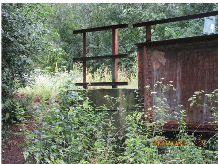
Zábradlí na křídle u OP1.
