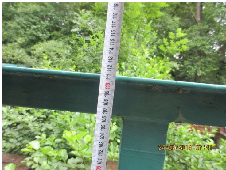
Výška zábradlí na levé straně.
