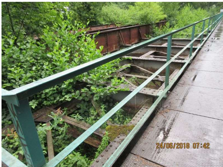
Zábradlí na levé straně mostu.
