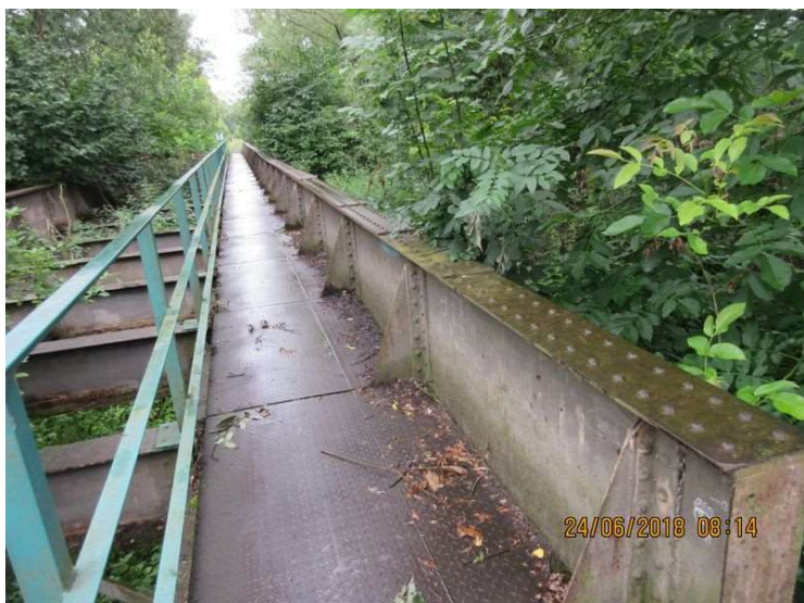
Zábradlí na levé straně mostu.
