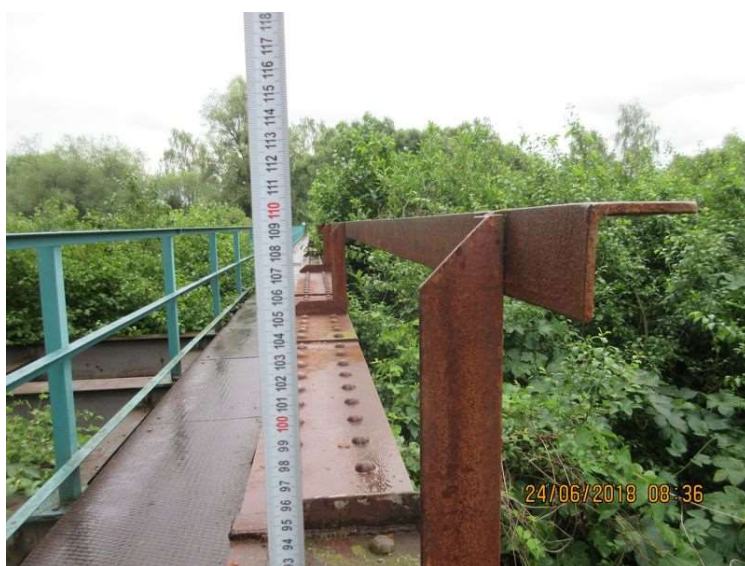
Výška zábradlí na pravé straně.
