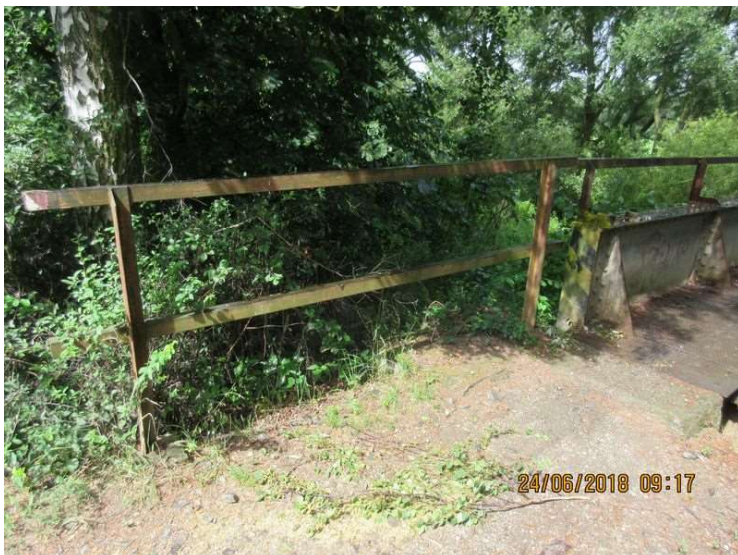
Zábradlí na křídle na pravé straně.
