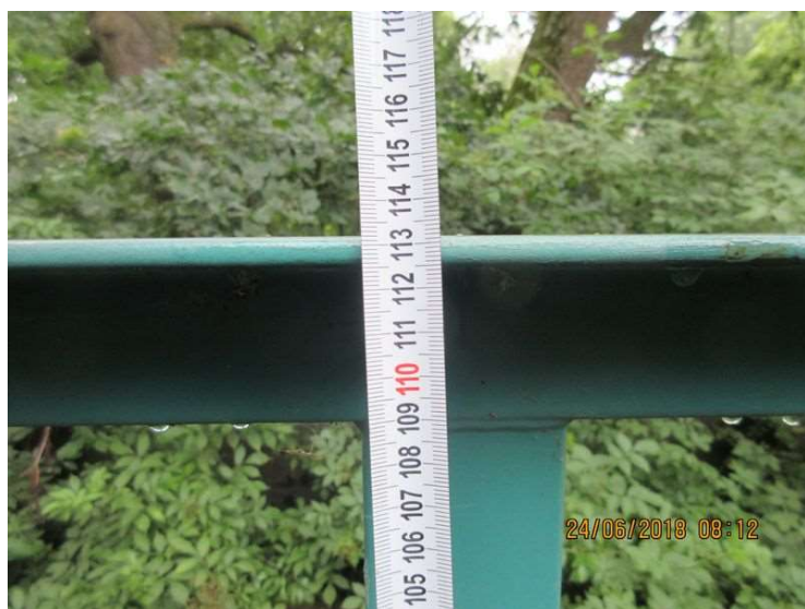
Výška zábradlí na levé straně.
