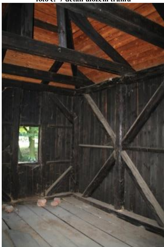
foto č. 8 vnitřní pohled
