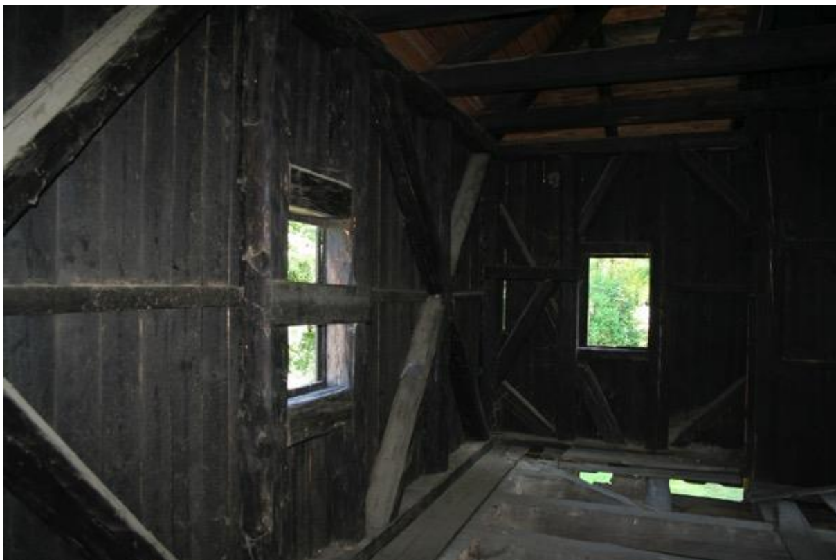
foto č. 15 vnitřní pohled
