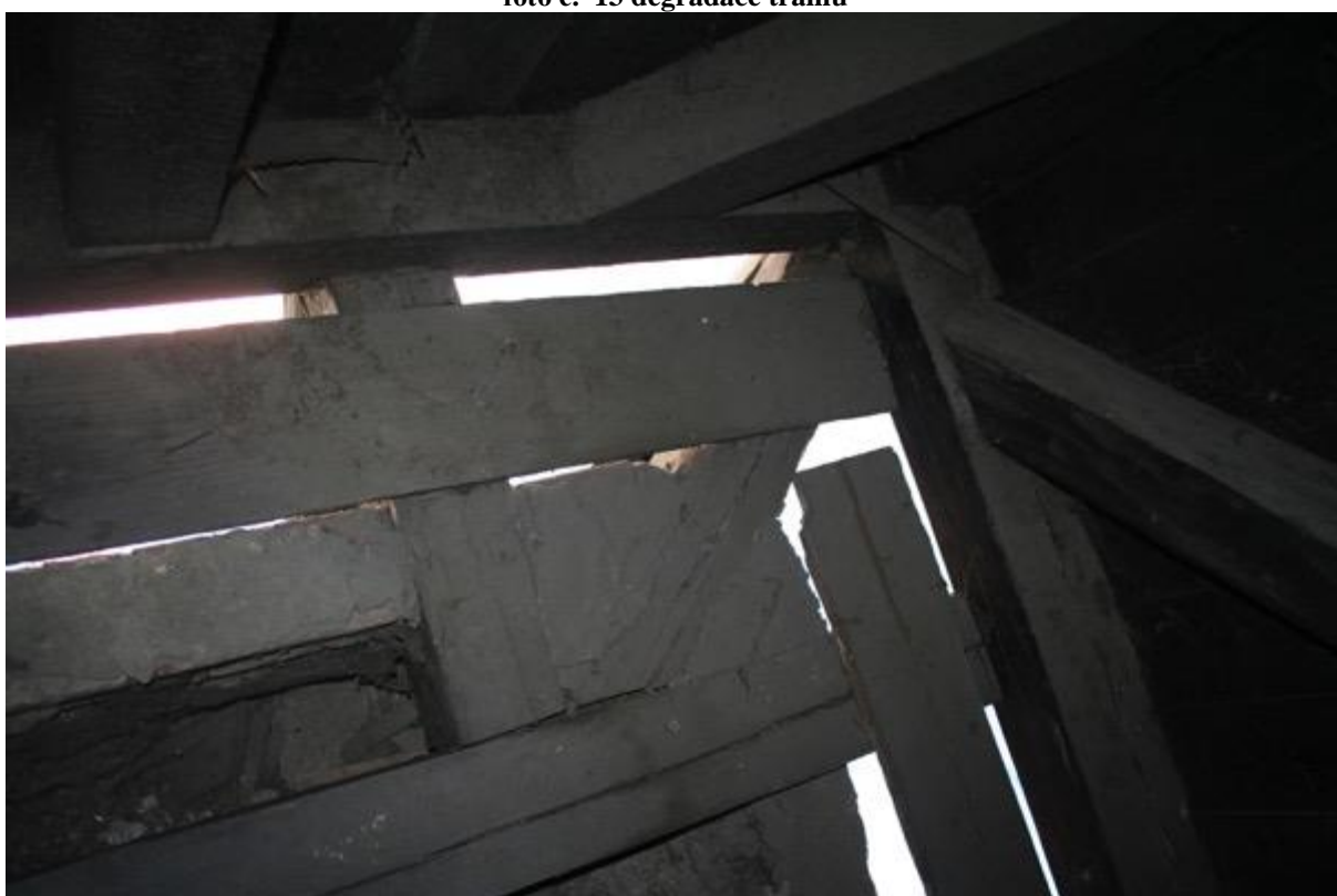
foto č. 14 detail uložení trámů v rohu
