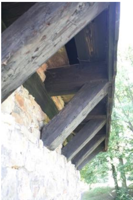
foto č. 7 detail uložení trámu
