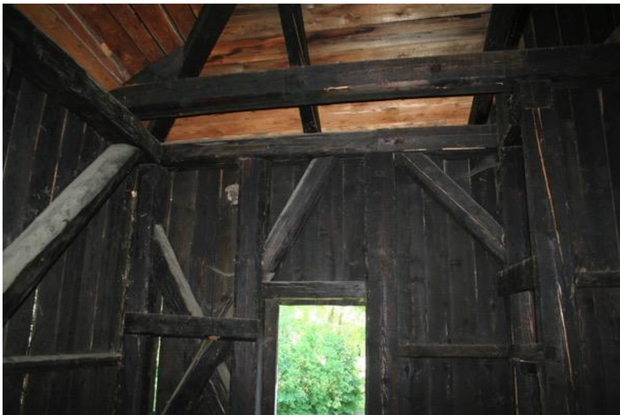
foto č. 11 vnitřní pohled
