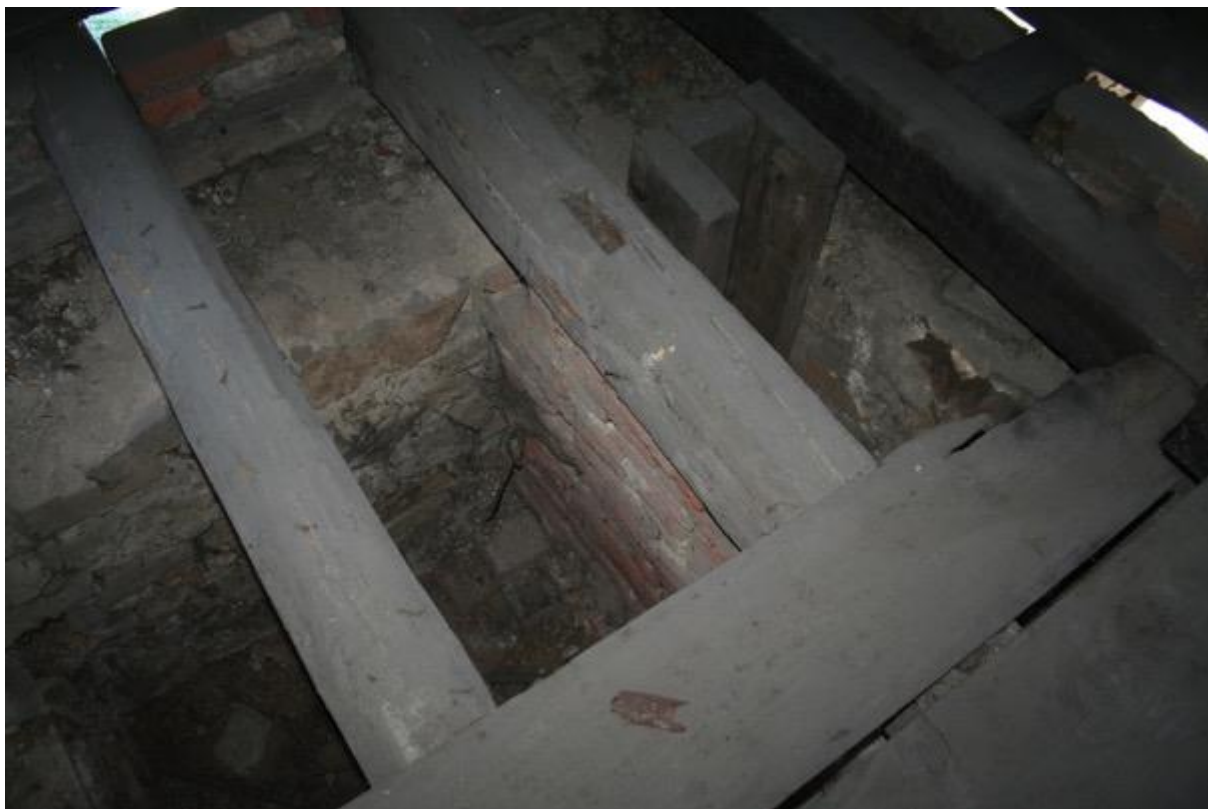
foto č. 17 odkryté podlahové trámy
