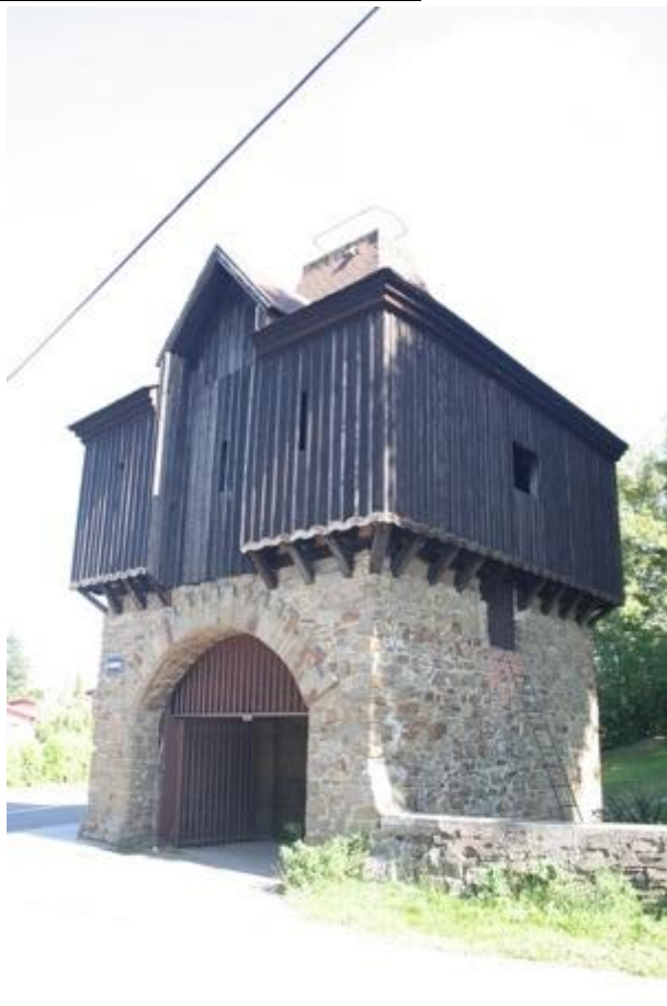
foto č. 1 – západní pohled
