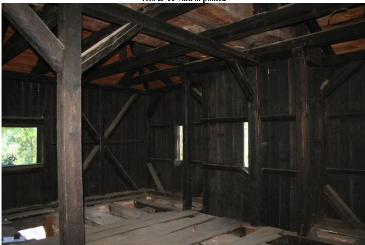
foto č. 12 vnitřní pohled
