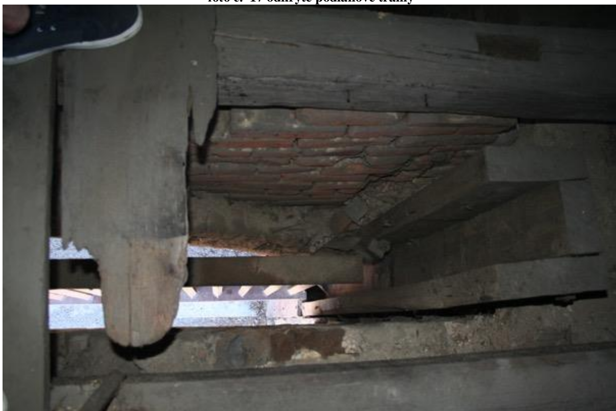
foto č. 18 prostup pro původní padací bránu
