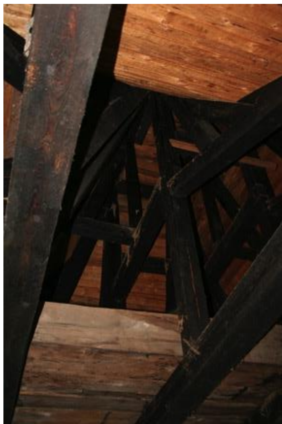
foto č. 9 krov středové sloupy k vrcholu
