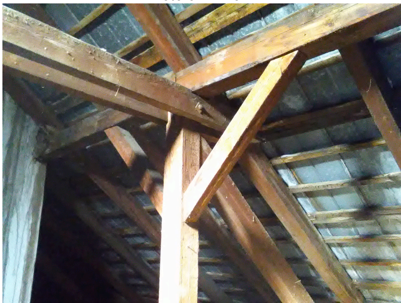
foto č.1. Krov
