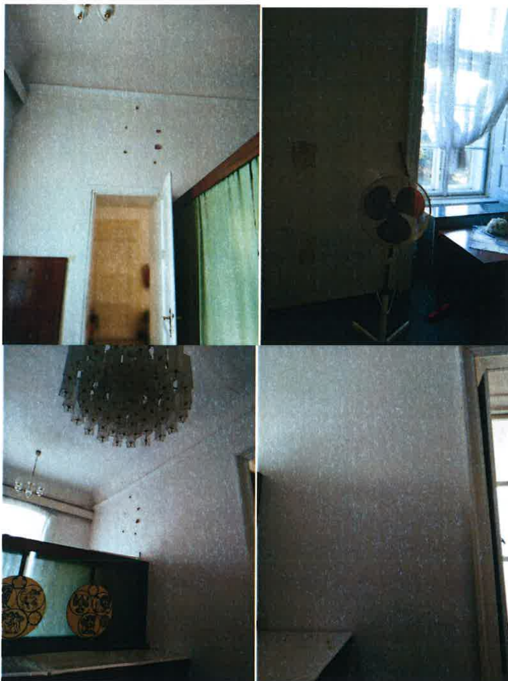
Interiér místností 204, 206 a 207
