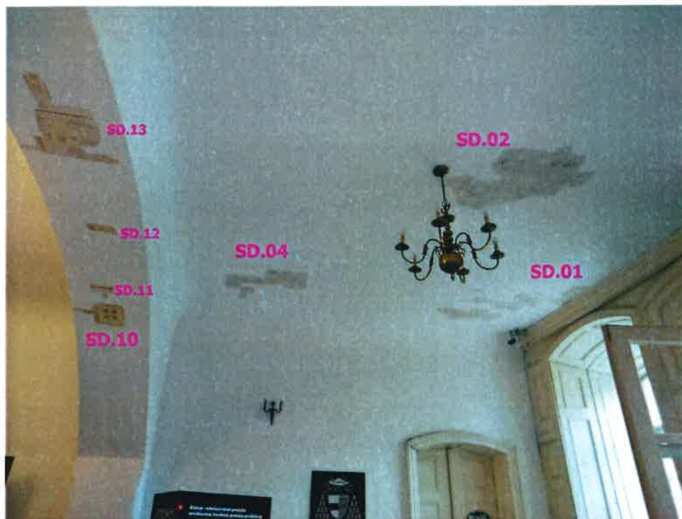
Umístění sond na stropě a klenbě.
