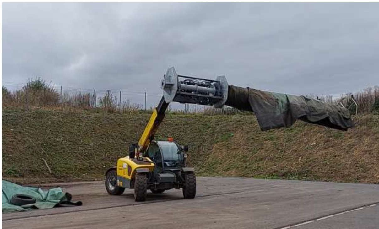
Ilustrativní foto práce s geotextilií. Jednoramenný navíječ
