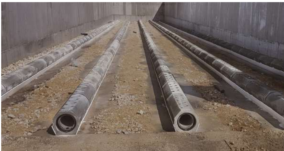
Pokládka potrubí na betonové pásy. Finální vrstva povrchu může být betonová či asfaltová.
