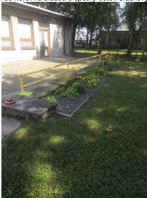
foto č.3. Ocelové tyčové zábradlí a dělící kamenná zídka (za zídkou nerovná dlažba a špatný odtok srážkových vod)
