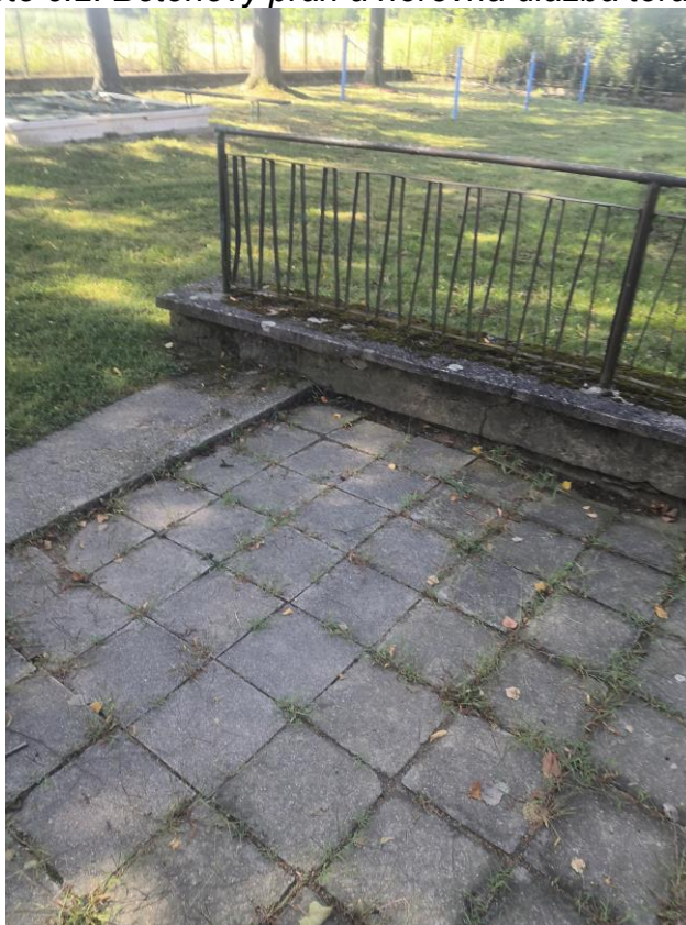
foto č.3. Ocelové tyčové zábradlí a dělící kamenná zídka (za zídkou nerovná dlažba a špatný odtok srážkových vod)
