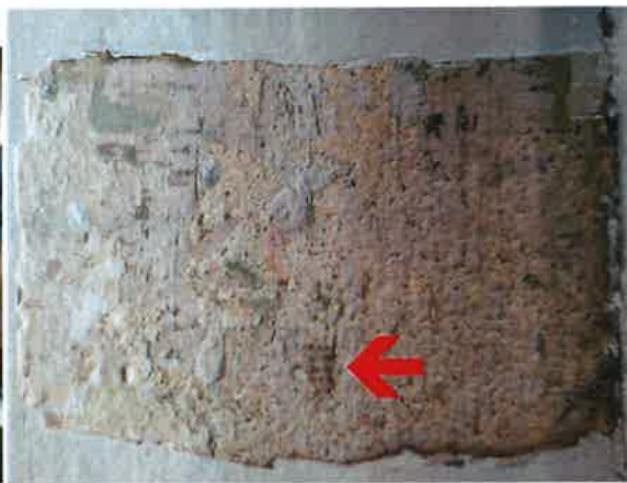
Sonda SC.01 s nálezem fragmentu novin na stěně.
