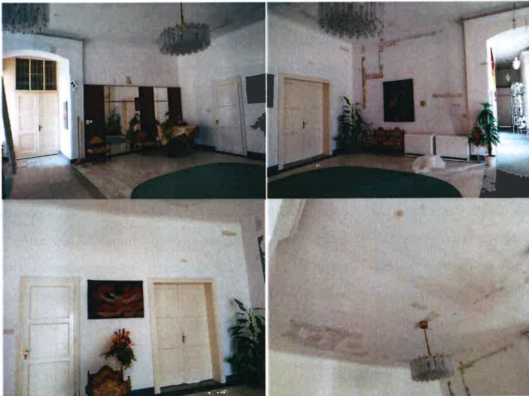
Pohled do interiéru schodišťové haly 2NP Nového zámku.
