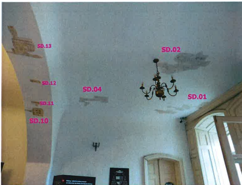
Umístění sond na stropě a klenbě.
