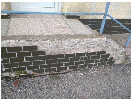
obr. /3/ Opadávající soklový obklad
