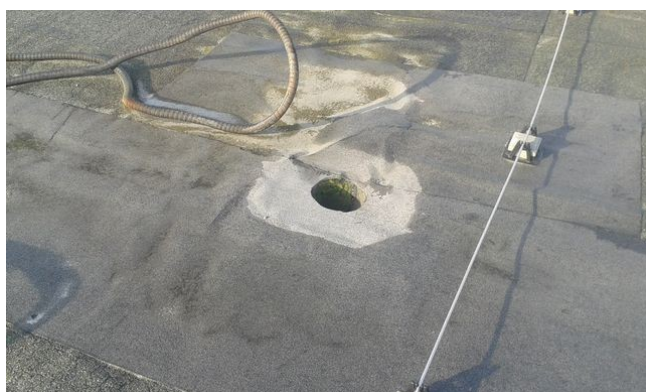
obr. /23/ Absence ochranného koše na střešní vpusti – riziko ucpání vtoku
