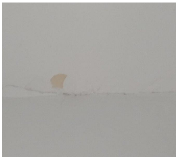
obr. /10/ Trhlina v místě styku stěny a stropní konstrukce
