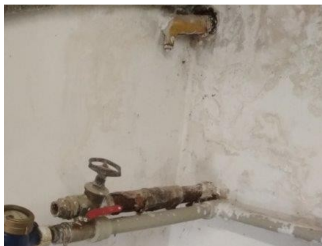
obr. /36/ V horním rohu se nachází původní rozvod plynu vedený v ocelovém potrubí
