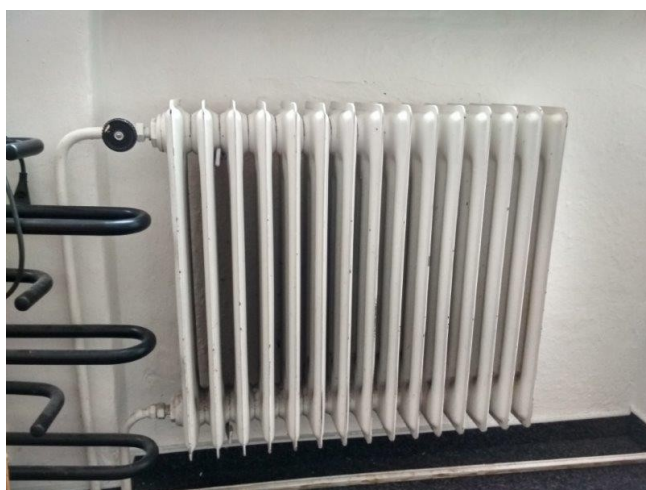
obr. /39/ Původní ocelové článkové otopné těleso
