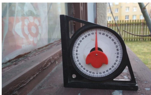
obr. /29/ Sklon oplechování parapetů původních okenních výplní je v některých místech nedostatečný (na fotce 1^\circ )
