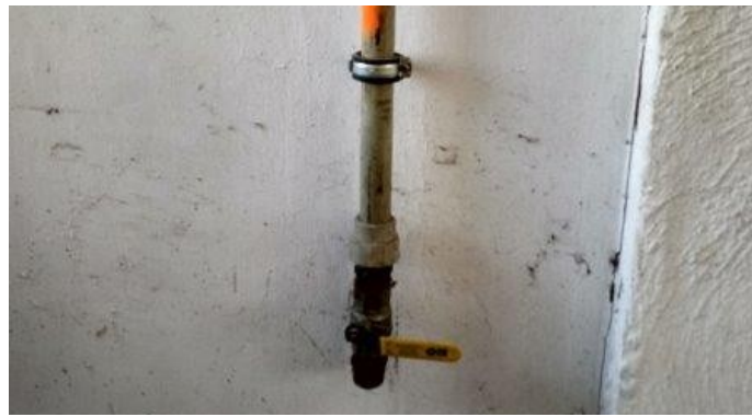
obr. /34/ V garážích jsou rozvody vody po rekonstrukci v plastových trubkách
