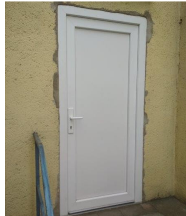
obr. /14/ Plastové vstupní dveře s plnou výplní
