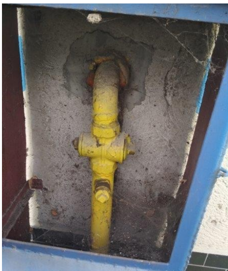
obr. /44/ Hlavní uzávěr plynu je umístěn v plechové skříni v místě hlavního vstupu do objektu stanice Městské policie
