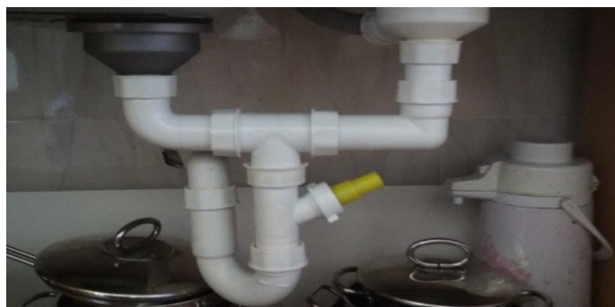
obr. /32/ Nové odpadní potrubí z místa kuchyňské dřezu.
