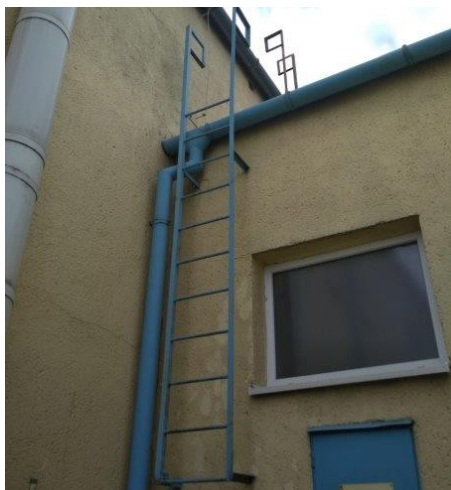
obr. /21/ Pro výlez na střešní rovinu za účelem údržby a revize komínového tělesa slouží fasádní žebřík
