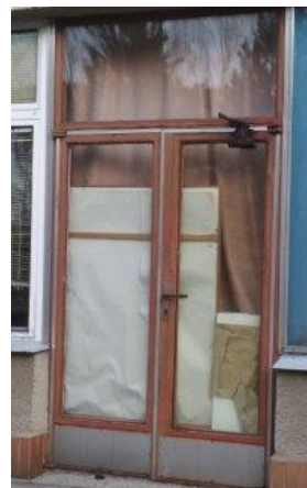
obr. /12/ Původní dvoukřídlá kovová dveřní výplň se zasklením z jednoduchého skla
