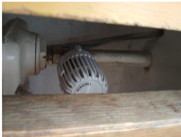
obr. /38/ Otopná tělesa jsou doplněna termostatickými hlavicemi
