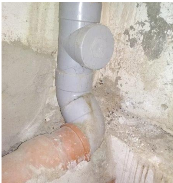
obr. /31/ Odpadní potrubí je po rekonstrukci vedeno v plastových trubkách
