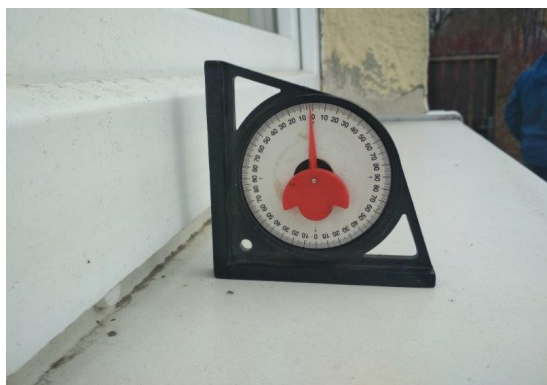
obr. /29/ Sklon parapetu je v některých místech jen 1^\circ
