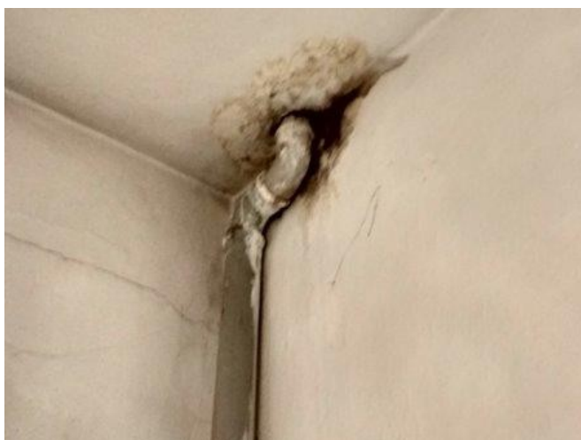
obr. /31/ Původní potrubí je na hranici své životnosti a v místě stropní konstrukce pravděpodobně dochází k lokálnímu zatékání odpadní vody
