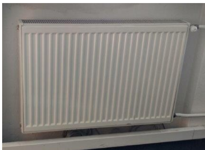
obr. /40/ Nové ocelové deskové otopné těleso
