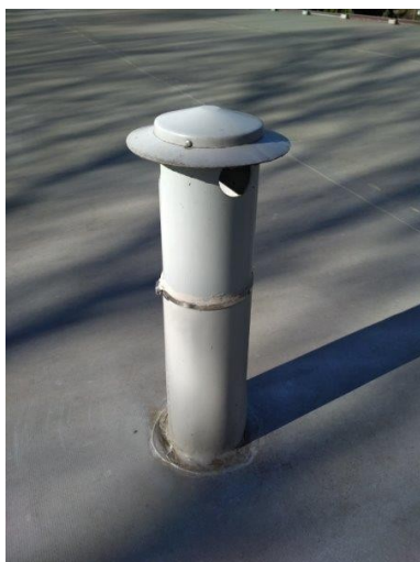
obr. /23/ Vytažení hydroizolace na odvětrání odpadního potrubí
