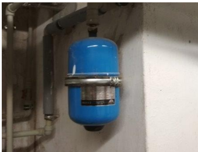
obr. /43/ Membránová expanzní nádoba
