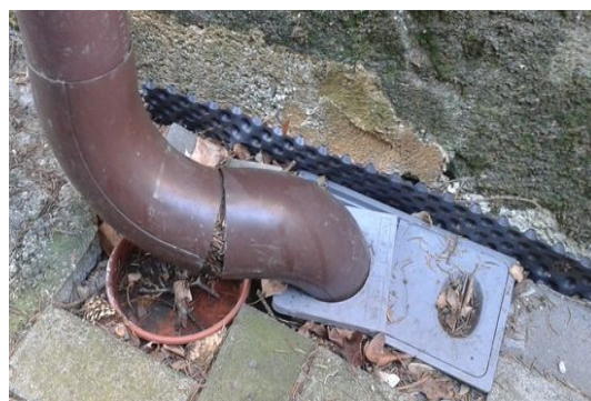
obr. /6/ Zanesený a nefunkční lapač střešních splavenin u vstupu do suterénu objektu
