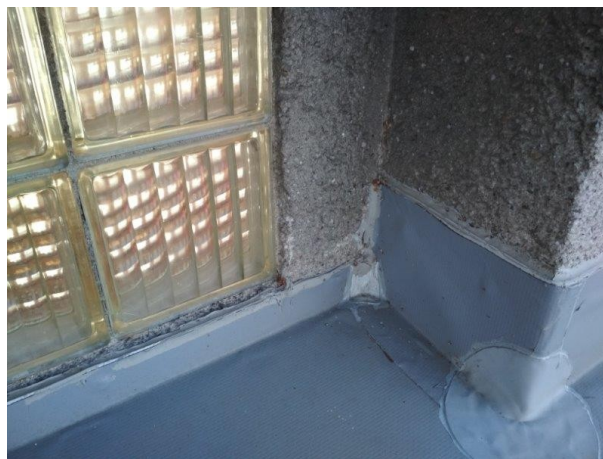
obr. /22/ V místě luxferového zdiva není fólie dostatečně vytažená nad rovinu střechy
