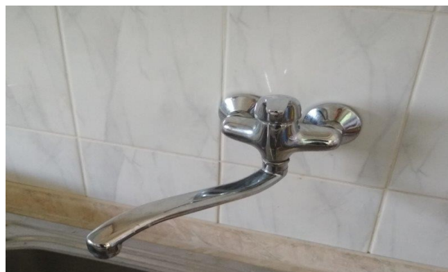
obr. /34/ Nástěnná páková baterie v místě kuchyně
