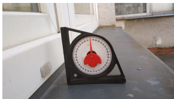
obr. /30/ Sklon oplechování parapetu zánovní okenní výplně je v na třetině posuzovaných míst nedostatečný (na fotce 0^\circ )
