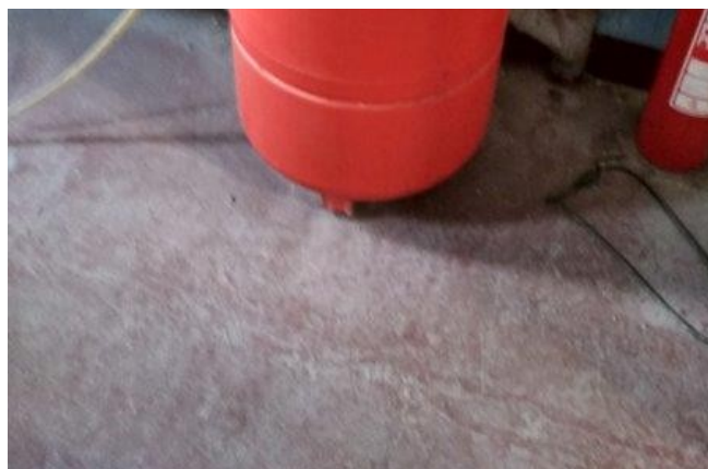
obr. /16/ Nášlapná vrstva kotelny je tvořena betonovou mazaninou
