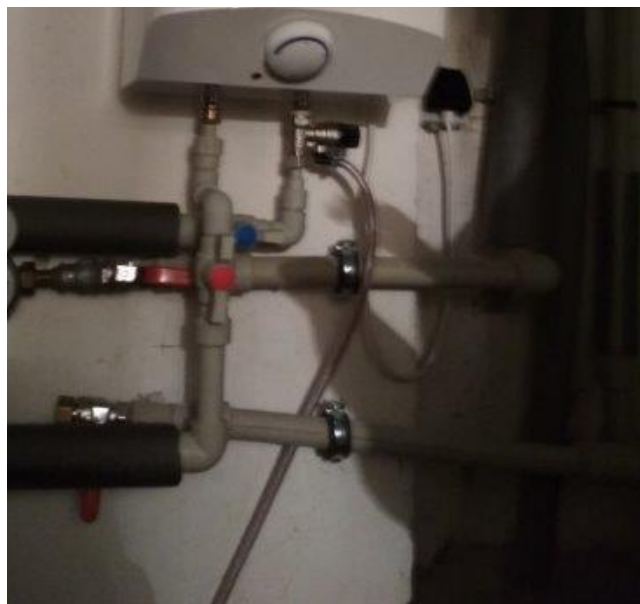
obr. /32/ Vnitřní rozvody vodovodu jsou po rekonstrukci vedeny v plastových trubkách
