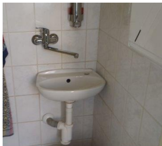
obr. /34/ Umyvadla jsou doplněna nástěnnými pákovými výtokovými armaturami
