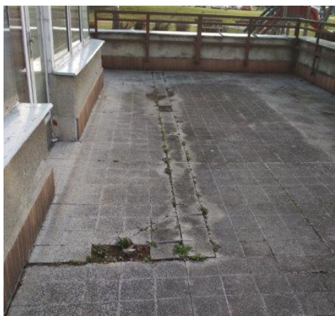
obr. /17/ Teracová dlažba předložených teras je poškozená a chybějící dlaždice
