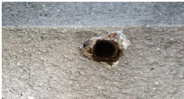
obr. /29/ Kovový prvek ve fasádě, který zhoršuje její tepelně izolační vlastnosti.
