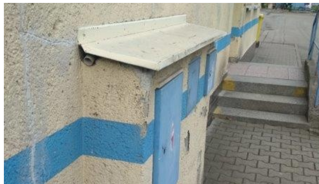
obr. /30/ Oplechování elektroinstalační skříně není ukončeno dilatační krycí lištou
