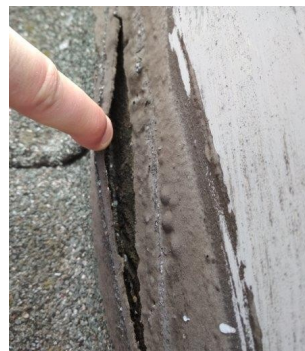
obr. /24/ Netěsnost v místě napojení asfaltového pásu na atiku
