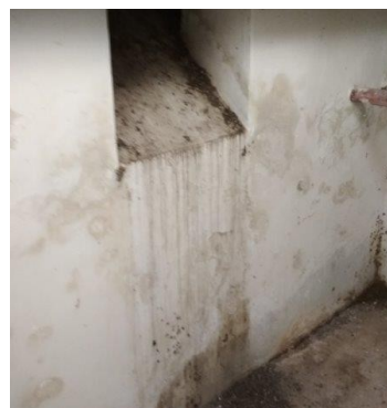
obr. /4/ Stěna pod suterénním oknem je smáčená dešťovou vodou
