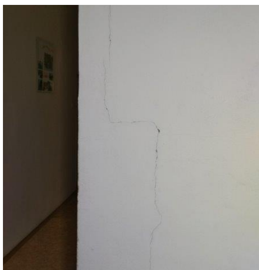
obr. /9/ Trhlina v místě svislé konstrukce
