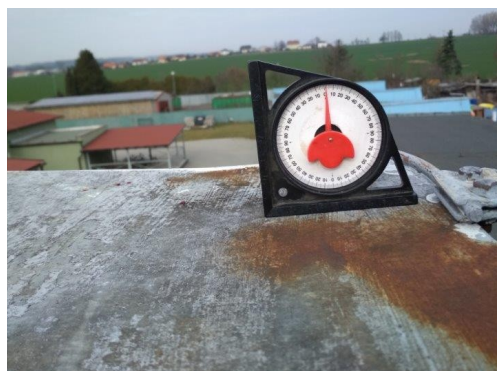
obr. /26/ Oplechování atiky objektu stanice Městské policie je zdegradováno a je místy v nedostatečném spádu (0°)
