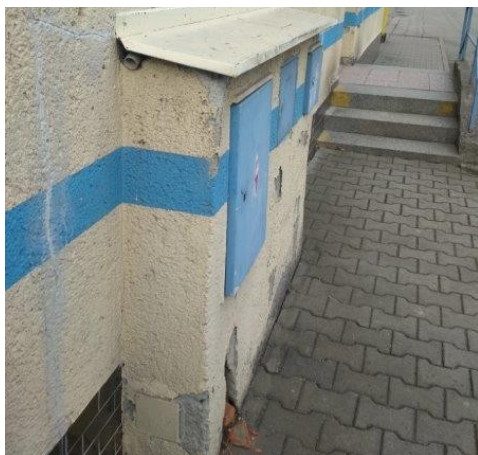
obr. /17/ Na severovýchodní straně objektu je okapový chodníček tvořen zámkovou dlažbou
