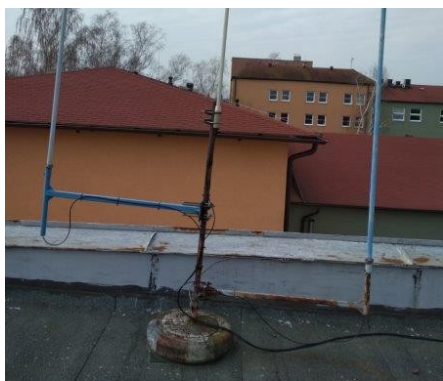
obr. /25/ Provizorně uchycená anténa
