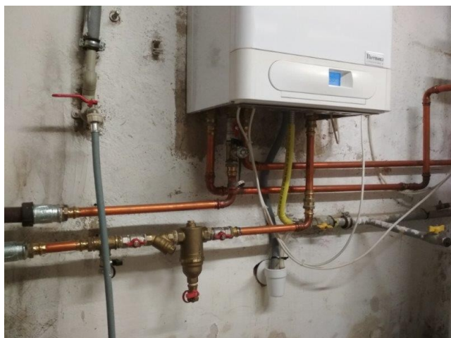
obr. /35/ Plynový kotel je napojen na nové vnitřní rozvody vedené v ocelových trubkách
