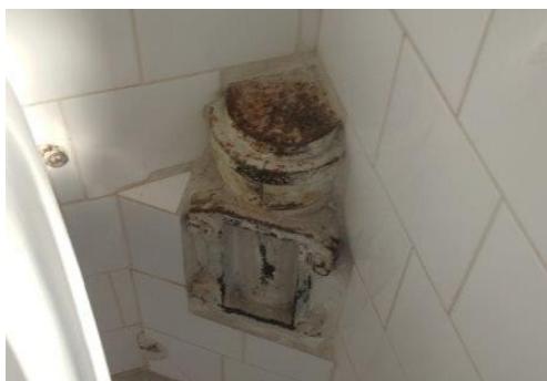
obr. /31/ Původní čistící tvarovka umístěná na WC
