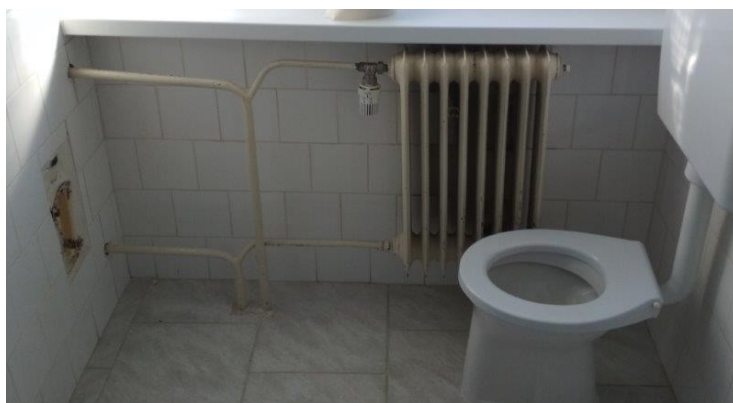
obr. /41/ Původní článkový radiátor doplněn novou termostatickou hlavicí
