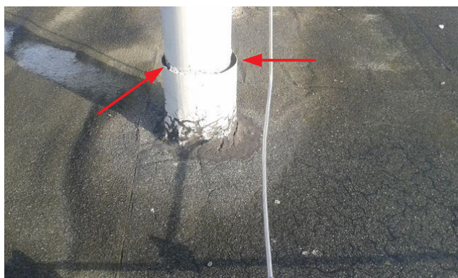
obr. /25/ Rizikové provedení prostupu střechy vykazující znaky netěsnosti v místě přechodu většího průměru potrubí na menší a také v místě napojení hydroizolace na prostup
