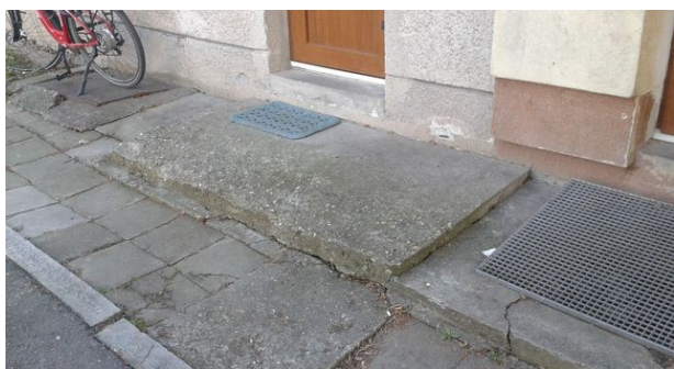
obr. /17/ Propadající se chodník v místě hlavního vstupu do objektu
