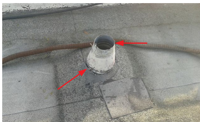
obr. /24/ Poškozený prostup střechy – chybí horní část prostupu, který by bránil zatečení do prostupu, napojení hydroizolace na prostup vykazuje netěsnosti
