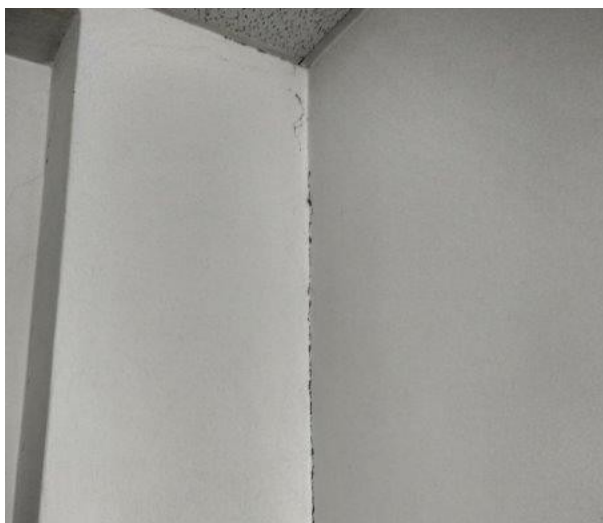
obr. /9/ V rozích stěn se nacházejí trhliny
