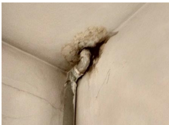
obr. /5/ V místě prostupu odpadního potrubí přes stropní konstrukci vznikají vlhké mapy
