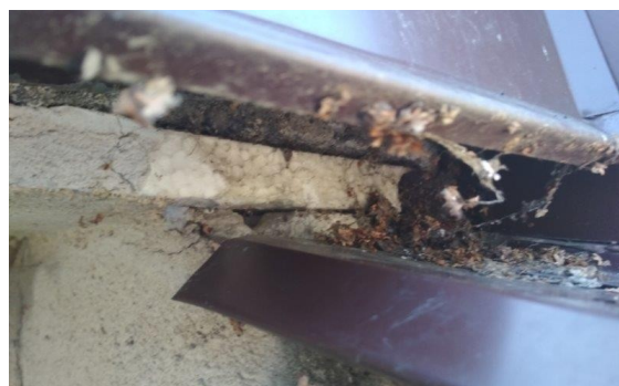
obr. /28/ Detail - nevhodného napojení klempířských prvků
