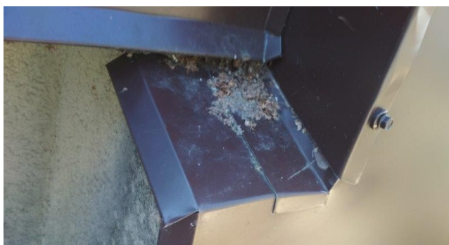
obr. /27/ Nevhodné napojení klempířských prvků - dochází ke smáčení omítky obvodového zdiva
