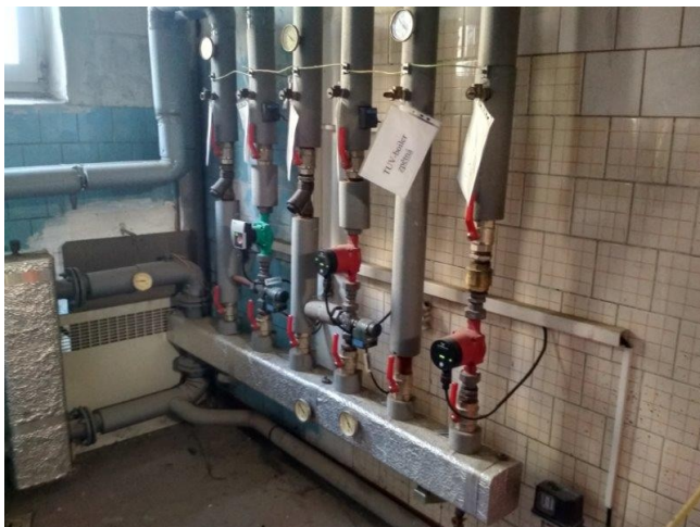
obr. /41/ Výměník v prvním nadzemním podlažím obr. /42/ Výměník v prvním nadzemním podlažím
