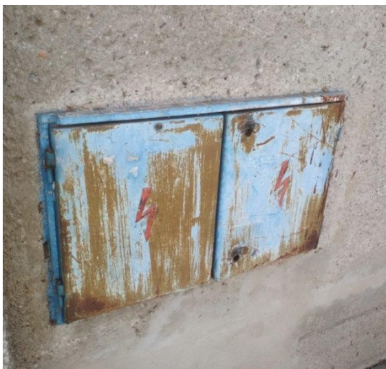
obr. /37/ Ochranný nátěr plechové skříňe je značně zdegradovaný
