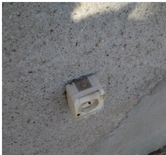
obr. /38/ Poškozená venkovní elektrická zásuvka
