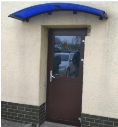
obr. /13/ Hliníkové vstupní dveře s izolačním dvojsklem
