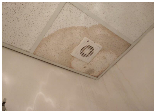
obr. /4/ Stopy po zatékání na stropním podhledu
