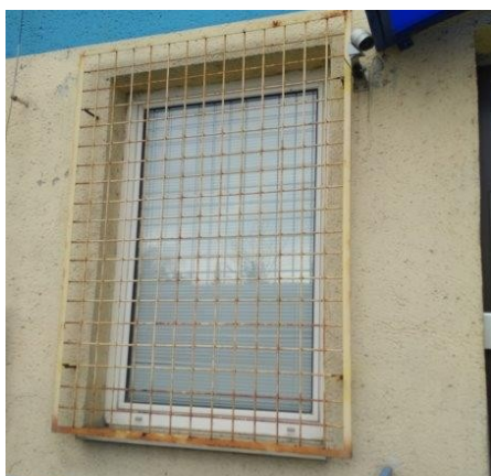
obr. /11/ Okenní mříže jsou zdegradované
