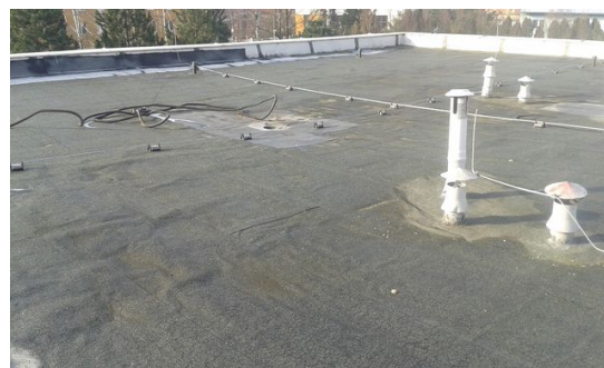
obr. /22/ Pohled na střešní rovinu jihozápadní části objektu s hydroizolací z asfaltových pásů
