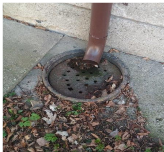
obr. /45/ Napojení dešťového svodu bez lapače střešních splavenin
