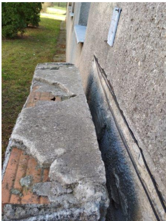
obr. /41/ Pilíř elektroinstalační skříně je ve velmi špatném stavu
