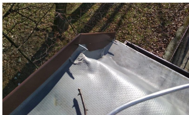
obr. /26/ Vyčnívající hroty vrutů z klempířských prvků
