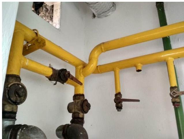
obr. /36/ Pohled na plynovodní rozvody v místě plynoměrné sestavy
