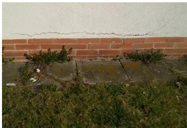
obr. /18/ Okapový chodníček se místy propadá a je tím snížena jeho účinnost
