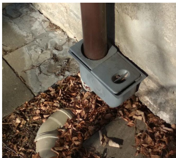
obr. /44/ Ležaté dešťové potrubí není v nezámrazné hloubce
