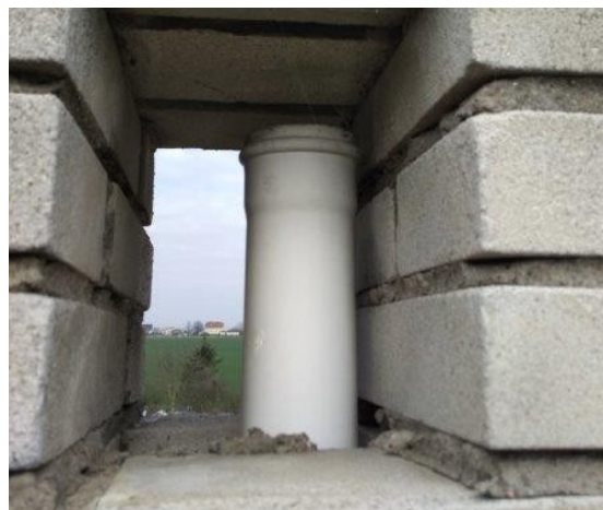
obr. /20/ V komínovém tělese je vyústěno odvětrání odpadního potrubí
