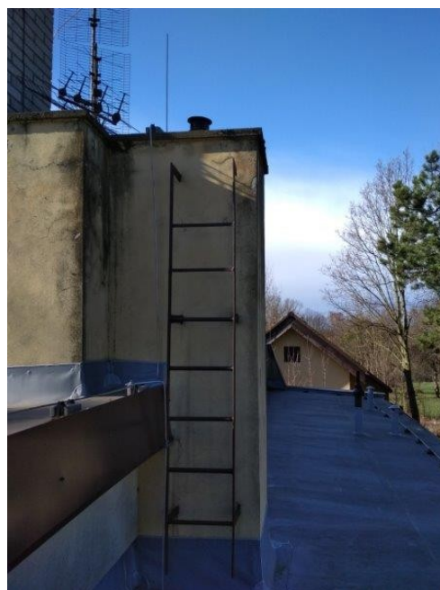
obr. /20/ K výlezu na komínové těleso slouží železný fasádní žebřík.
