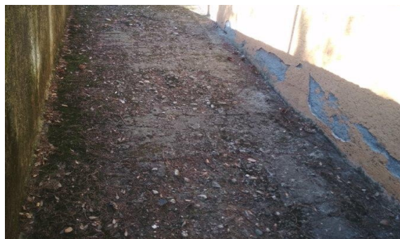
obr. /16/ Nášlapná vrstva rampy je již značně zdegradovaná
