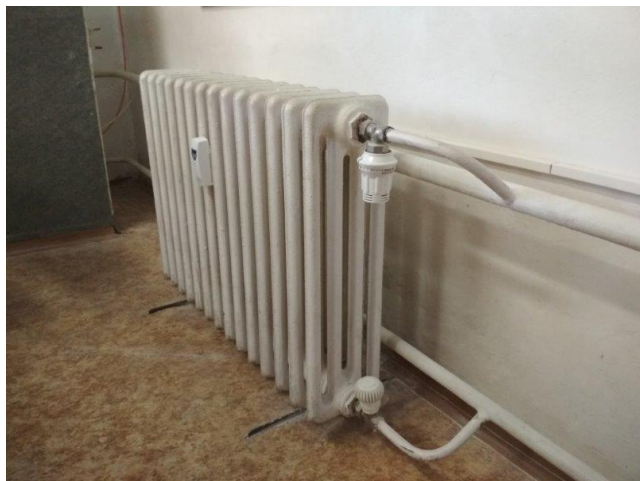
obr. /37/ Původní litinový článkový radiátor
