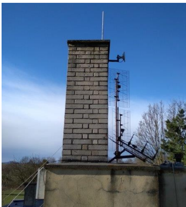
obr. /19/ Komínový plášť je vyzděný z vápenopískových cihel
