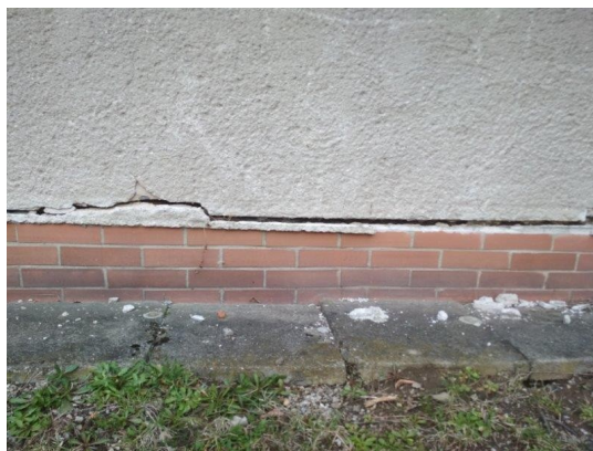
obr. /6/ Trhlina ve styku fasády a soklu objektu
