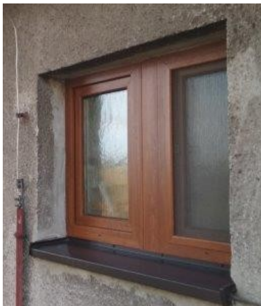
obr. /11/ Plastová okna s izolačními dvojskly
