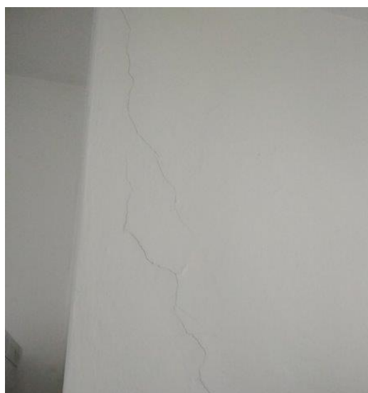
obr. /10/ Trhlina v místě svislé konstrukce
