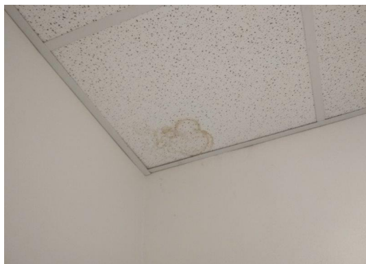
obr. /3/ Stopy po zatékání na stropním podhledu
