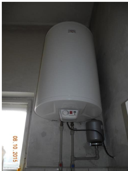
Obr. 4 – elektrický ohřívač TV
