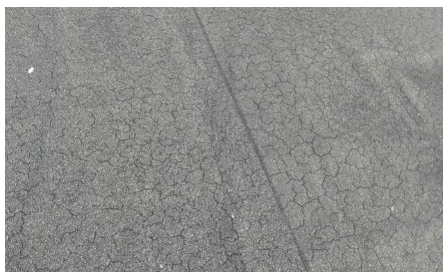
obr. /26/ Pohled na degradaci povrchu povlakové hydroizolace – končící trvanlivost
