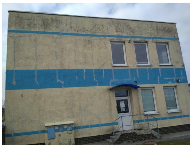
obr. /8/ V obvodovém zdivu se nachází značné množství trhlin, hlavně v místě styku stěnových panelů
