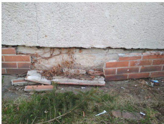
obr. /5/ Soklový obklad obvodových stěn je značně zdegradovaný a odpadává
