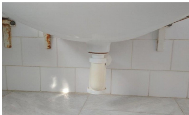
obr. /33/ Ochranný nátěr nástěnného uchycení umyvadla je zdegradovaný
