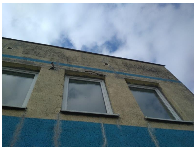
obr. /7/ V místě nadpraží okenního otvoru opadává omítka a hrozí degradace nosné nadokenní konstrukce
