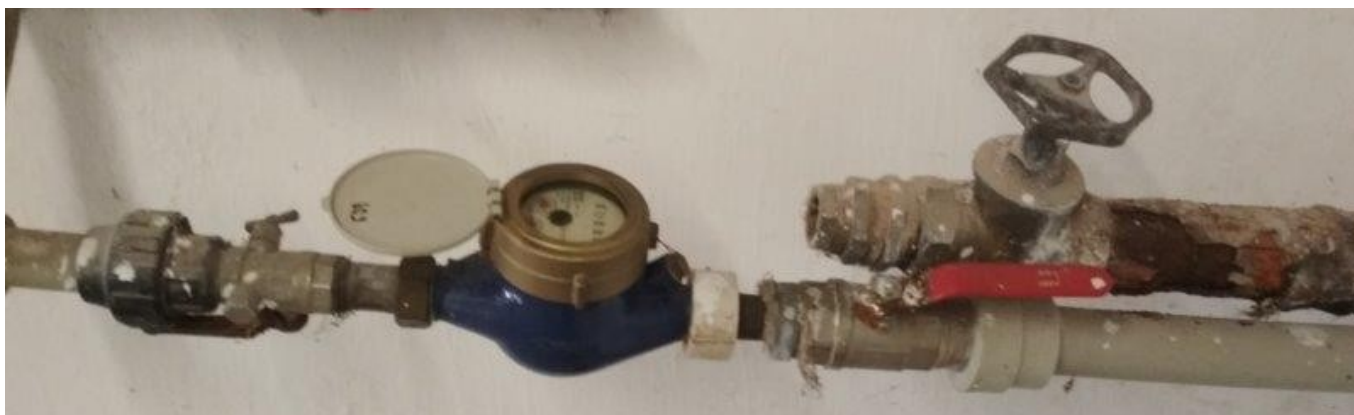
obr. /46/ Vodoměrná sestava
