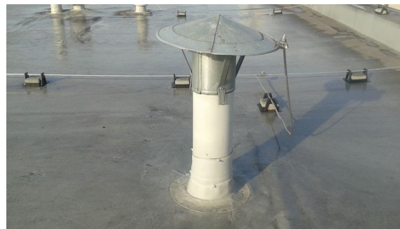
obr. /28/ Fólie je vytažena na prostupy vystupující nad střešní rovinu bez ukončující objímky
