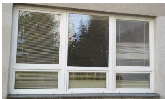
obr. /13/ V místě hlavního vstupu se nachází plastová okenní výplň s izolačním dvojsklem
