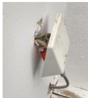
obr. /38/ Některé elektroinstalační krabice jsou poškozené
