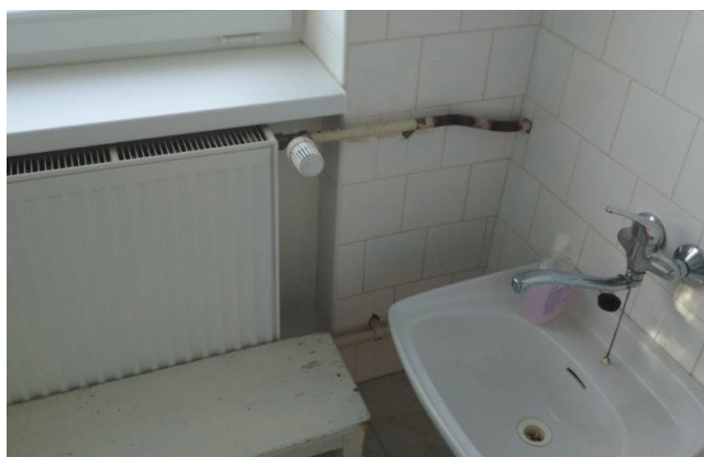
obr. /40/ Rozvody otopné soustavy jsou vedeny v původním ocelovém potrubí
