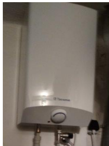
obr. /40/ Zásobníkový ohřívač teplé vody
