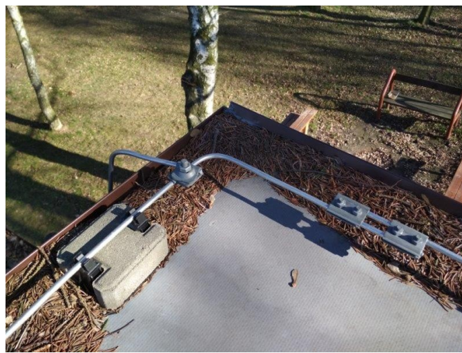
obr. /24/ Spad nečistot na povlakové hydroizolaci
