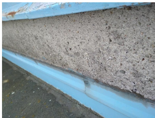
obr. /28/ V místě napojení asfaltového pásu na konstrukci vystupující nad střešní rovinu není asfaltový pás dostatečně vytažen
