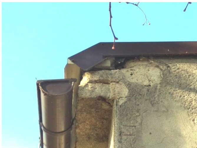
obr. /7/ Trhliny na římse v místě podokapního žlabu
