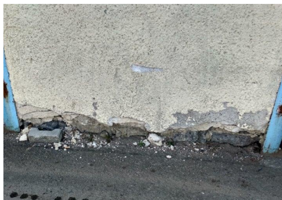
obr. /4/ V místě garáží dochází k degradaci povrchových úprav fasády
