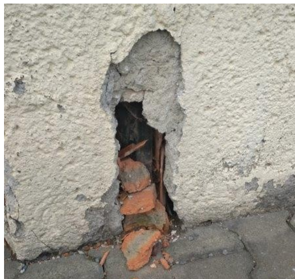
obr. /45/ Přístavek elektrické energie je poškozený a vlivem povětrnosti může docházet k degradaci elektroinstalace
