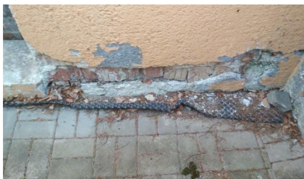
obr. /5/ Ukončení nopové fólie na fasádě objektu u vstupu do suterénu objektu
