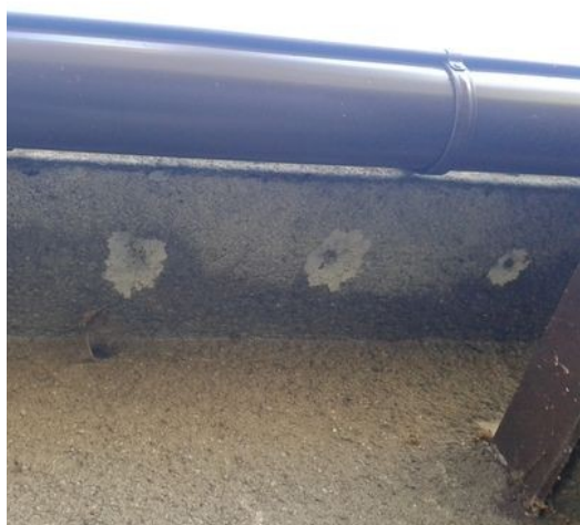
obr. /9/ Trhliny v římse vznikly s největší pravděpodobností při přikotvení střešního pláště k římse
