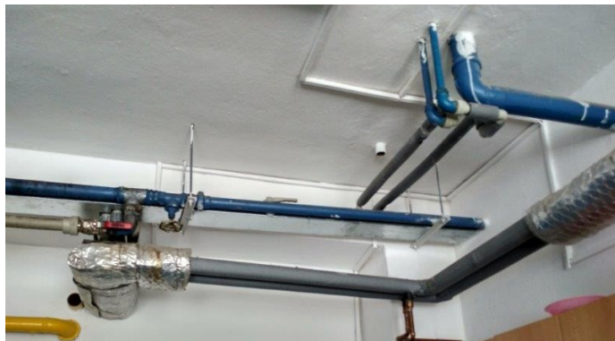
obr. /33/ Stávající vedení rozvodů vody
