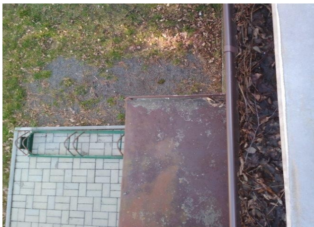
obr. /21/ Podokapní střešní žlab je zanesen nečistotami, které brání jeho účinnosti
