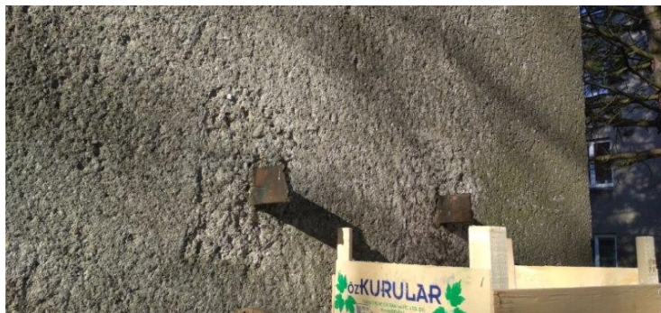
obr. /30/ Ukotvení původního žebříku na plochou střechu vytváří lokální tepelný most.
