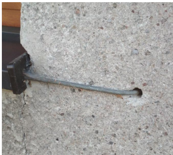
obr. /8/ Prostup vedení zemního drátu skrz obvodové zdivo a trhlina v místě okenního parapetu
