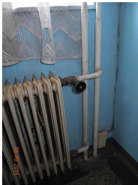
Obr. 5 – Stoupačky a přípoj k otopnému tělesu.
