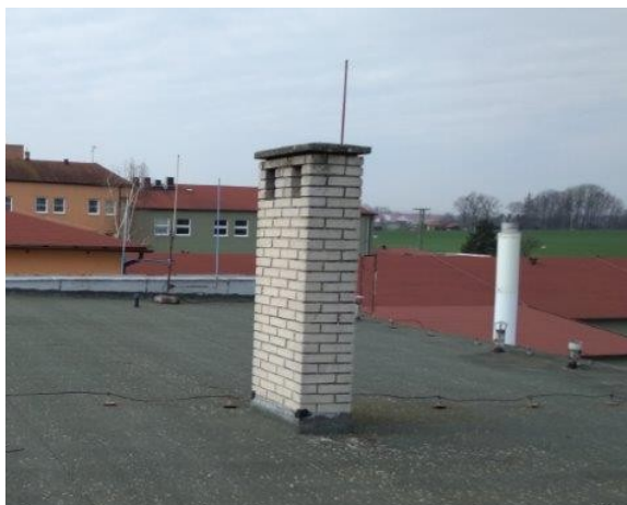
obr. /19/ Pohled na komínové těleso vyžděné z vápenopískových cihel
