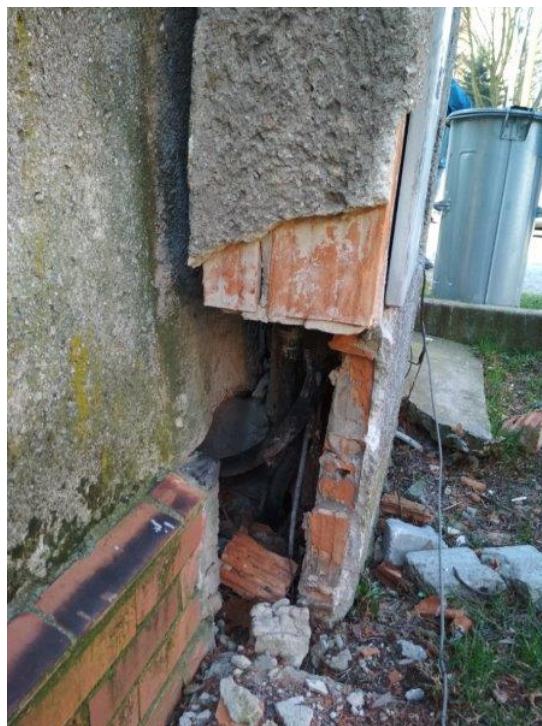
obr. /42/ Rozpad obezdívky pilíře elektroinstalační skříně
