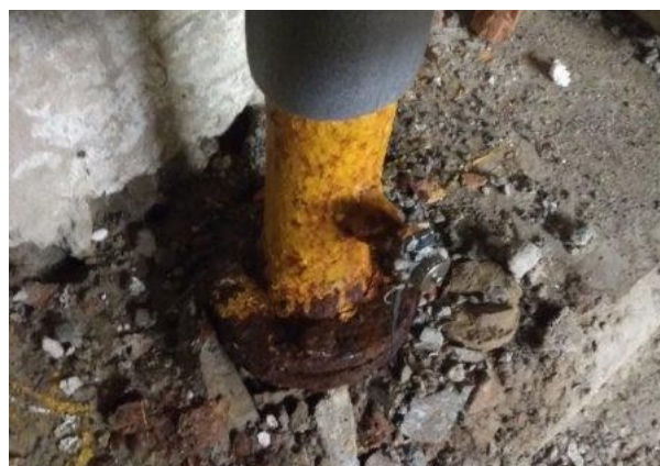
obr. /44/ V místě napojení plynovodu na přípojku je spojovací kus nadměrně zdegradovaný
