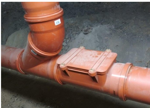
obr. /27/ Ležaté potrubí je v místě styku dvou větví odpadního potrubí doplněno čistící tvarovkou
