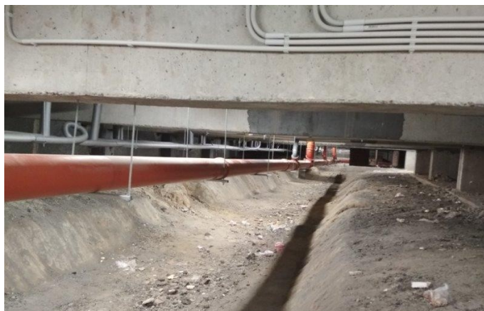
obr. /28/ Ležaté odpadní potrubí je v suterénu ukotveno ke stropní konstrukci pomocí speciálních kotev
