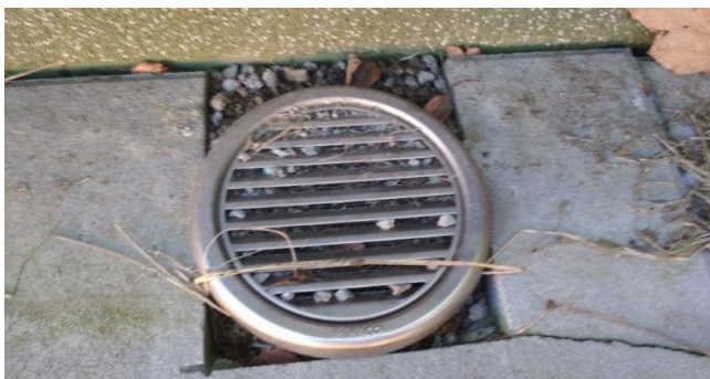
obr. /5/ Pozinkovaná ventilační mřížka ukončující ventilační potrubí
