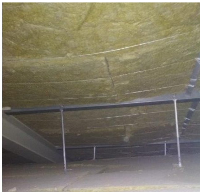
obr. /22/ Střešní plášť byl při rekonstrukci zateplen minerální vatou
