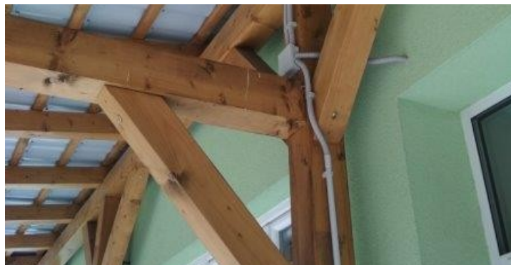
obr. /26/ Na terasách je střešní krytina vynášena pomocí latí a kroekvních trámů
