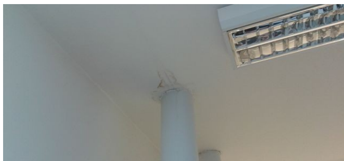
obr. /7/ Vlhká mapa v místě prostupu potrubí přes stropní podhled
