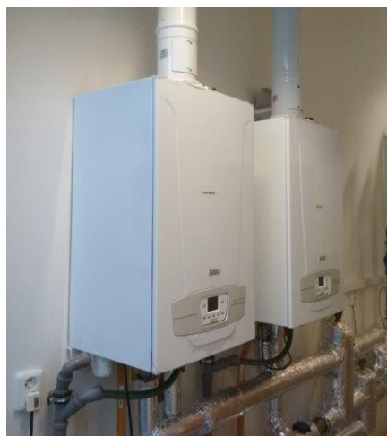
obr. /40/ K vytápění objektu slouží plynový kotel umístěný v třetím nadzemním podlaží
