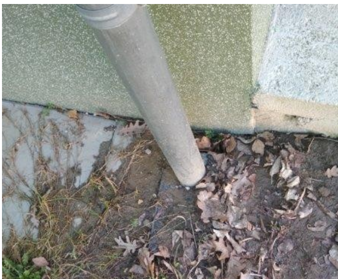
obr. /42/ Některé lapače střešních splavenin jsou zaneseny biologickým odpadem
