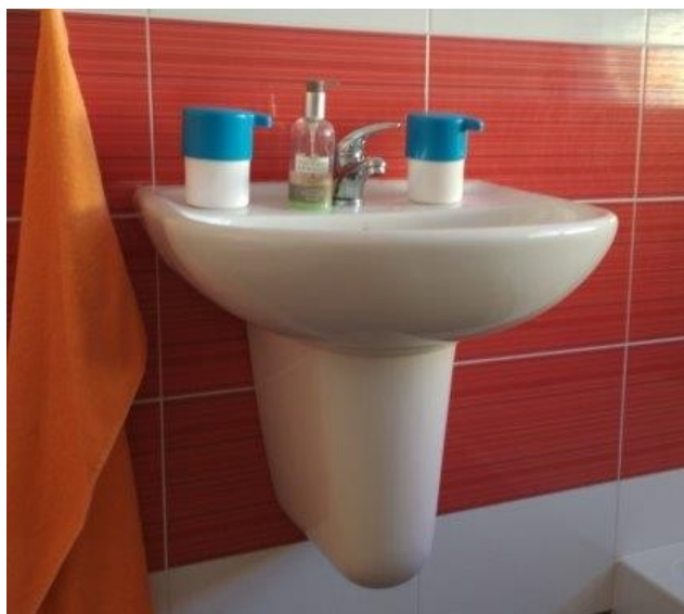
obr. /31/ Umyvadla jsou vybavena pákovou stojánkovou výtokovou armaturou
