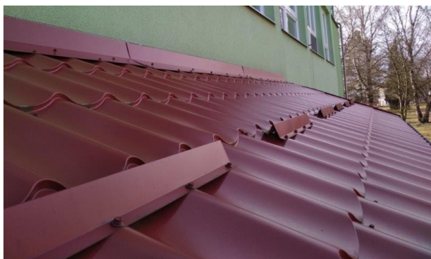
obr. /23/ Střešní rovina vstupních stříšek je doplněna systémem protisněhových zábran
