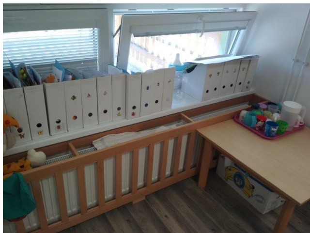
obr. /37/ Otopná tělesa jsou chráněna dřevěným obložením, aby bylo sníženo riziko poranění uživatelů objektu
