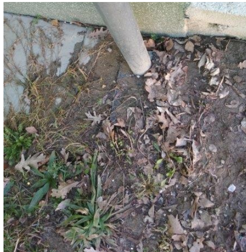
obr. /20/ V místě lapače střešních naplavenin je okapový chodníček zanesen nečistotami a dochází k akumulaci srážkové vody v blízkosti základových konstrukcí
