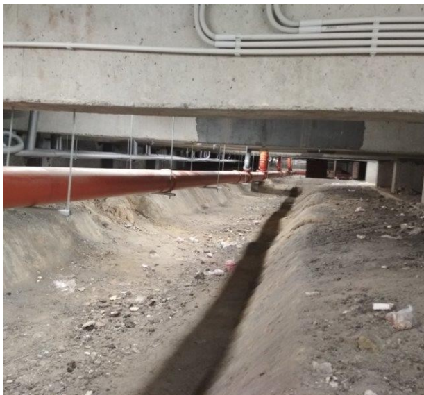
obr. /3/ Konstrukce podlahy prvního nadzemního podlaží je vynášena pomocí železobetonových průvlaků, které jsou uloženy na původní železobetonové pásy
