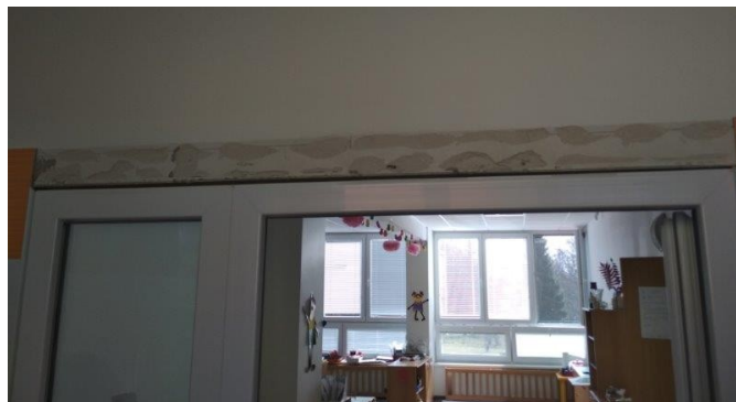
obr. /12/ V místě WC dochází k opadávání obkladu z překladových konstrukcí
