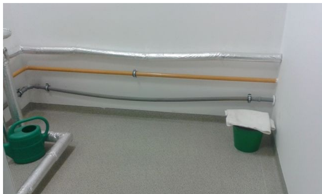
obr. /29/ Průhyb ležatého odpadního potrubí vlivem překročení maximální vzdálenosti podpor
