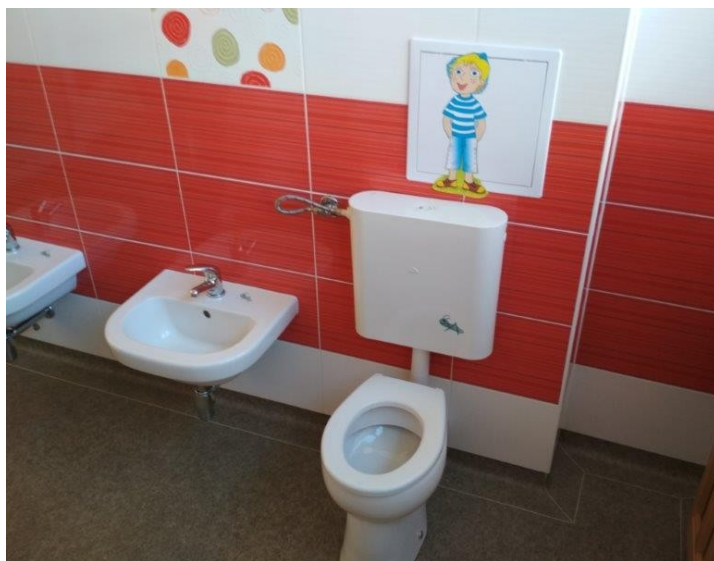
obr. /32/ Klozety jsou doplněny nástěnnou splachovací nádrží
