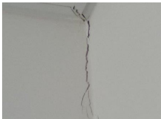
obr. /10/ Trhlina v místě styku stropního průvlaku a svislé nosné konstrukce
