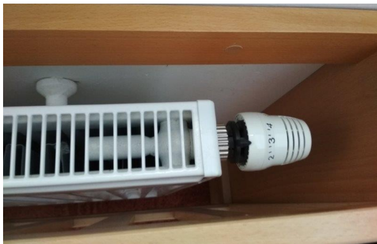
obr. /38/ Deskové ocelové radiátory jsou doplněny termostatickými hlavice
