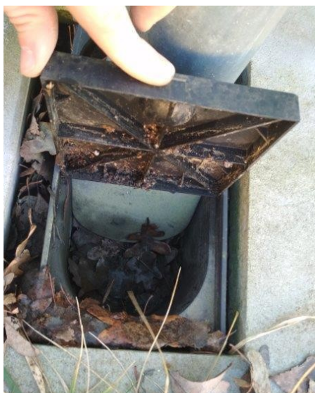
obr. /41/ Lapač střešních splavenin je zanesen listím
