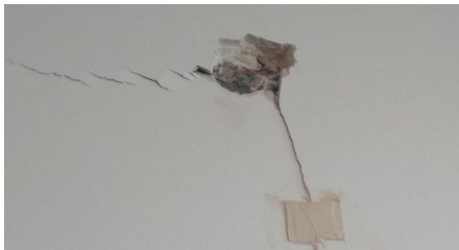
obr. /11/ Trhliny jsou monitorovány pomocí sádrových terčů
