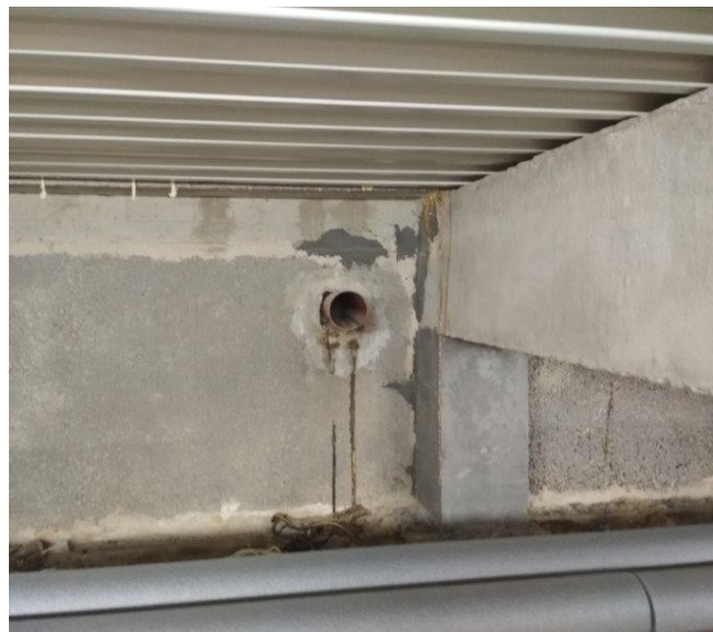
obr. /4/ Obvodové stěny technického podlaží jsou tvořeny původními betonovými stěnami
