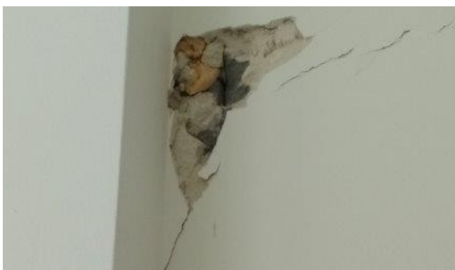
obr. /9/ V nosných i nenosných stěnách dochází k vzniku trhlin vlivem nadměrné deformace
