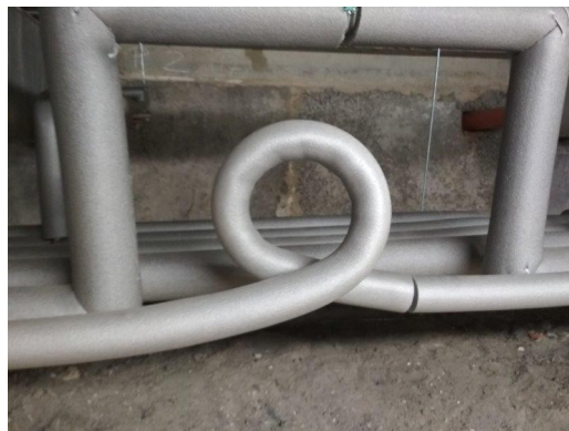
obr. /30/ Dilatace ležatého vodovodního potrubí
