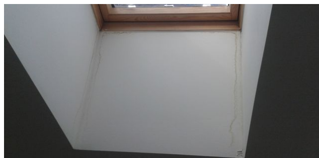
obr. /8/ V rozích ostění střešních oken vznikají vlhké mapy
