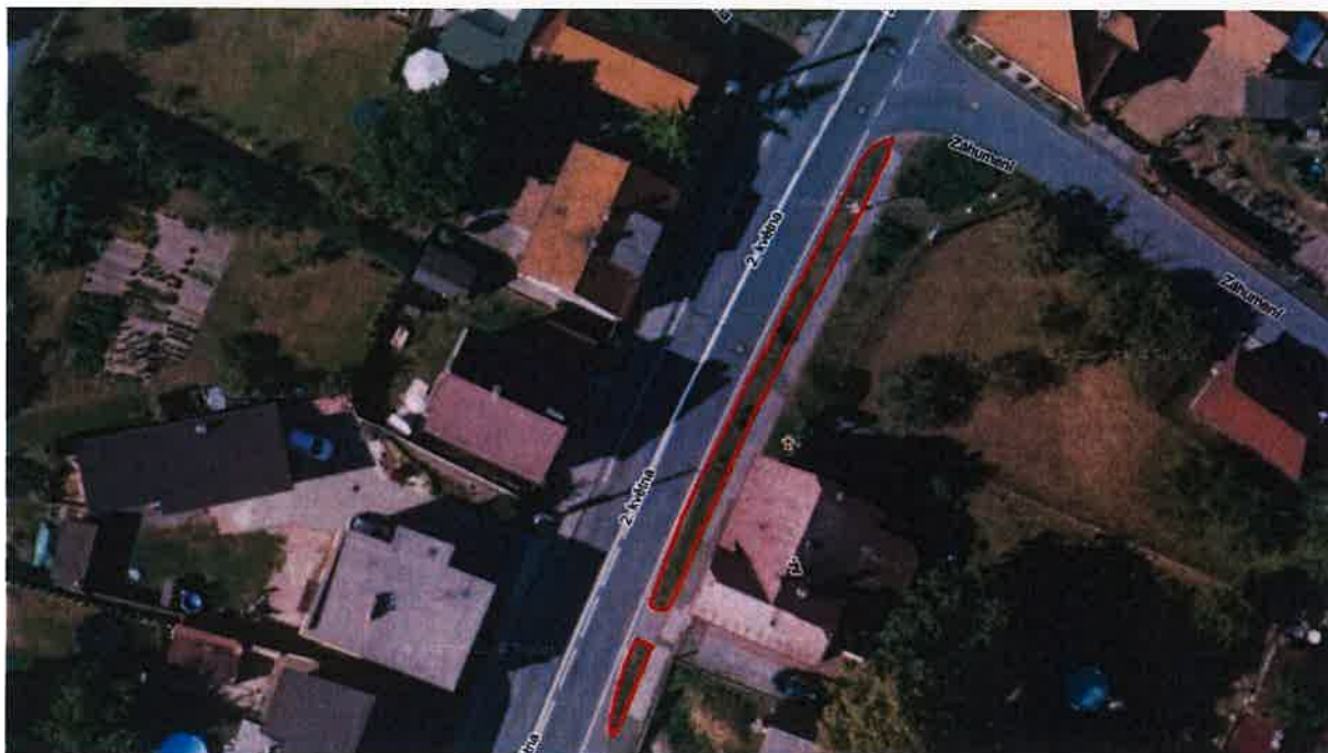
Obr. 1 – ul. 2.května, Studénka I – před budovou Církve čes. husitské
