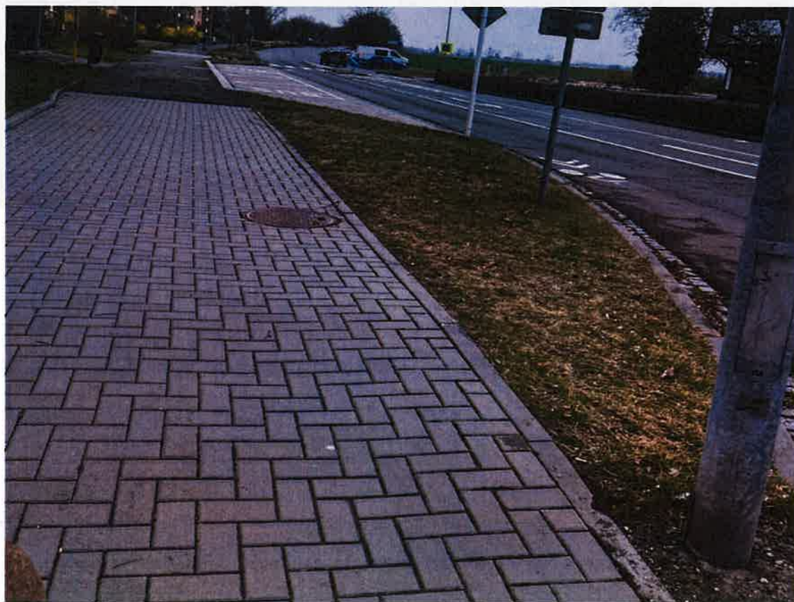
Obr. 3 – ul. Sjednocení – zastávka Kotvice – plocha B – pohled směr Studénka I
