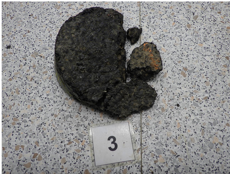
Vývrt JV3 - detail
