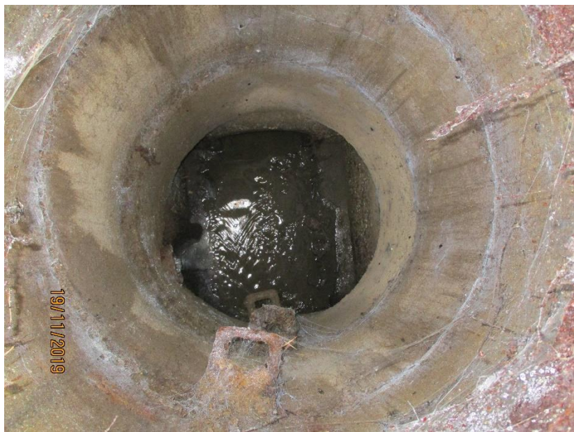
Obr. 2 šachta Š2 stoky H, splašková (jednotná) u domu č.p. 9, hl. 2,83 m, přítok DN800 beton, DN200 beton, odtok 800 beton
