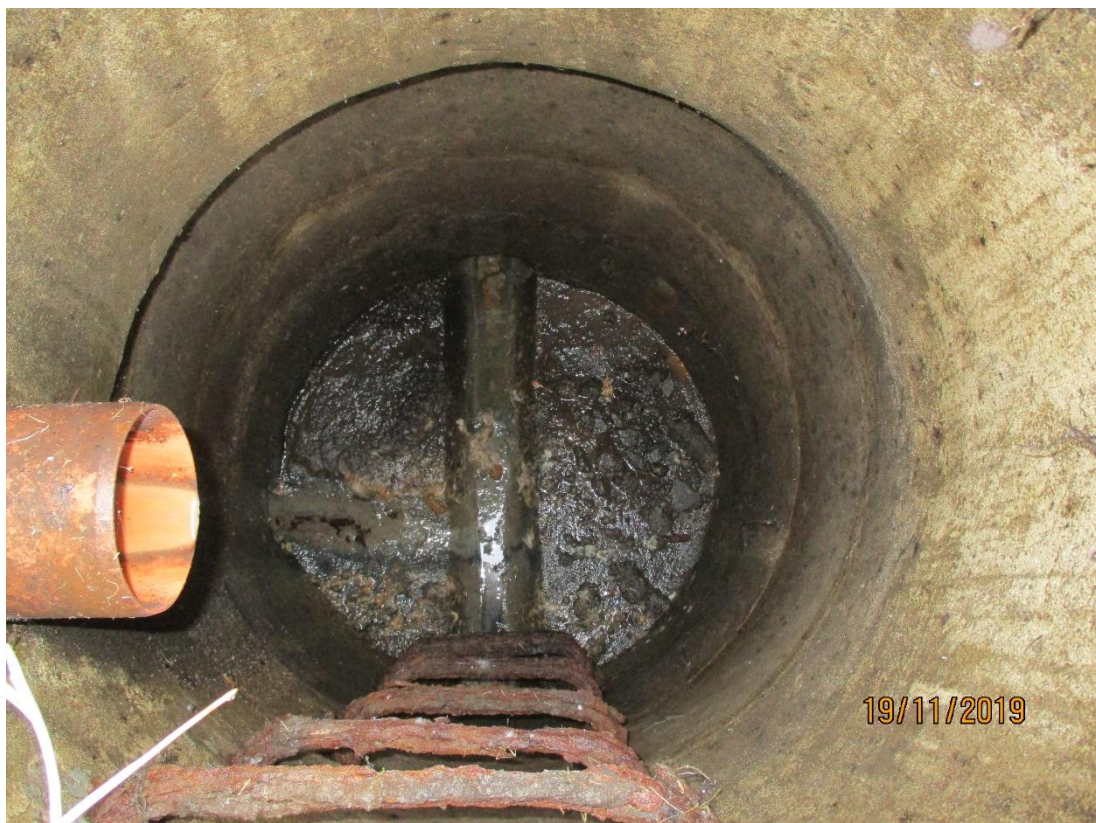
Obr. 23 šachta Š2 stoky H3-1, splašková (jednotná), hl. 1,99 m, přítok DN300 beton. DN200 plast, odtok DN300 beton
