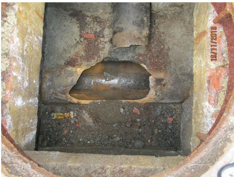
Obr. 9 šachta Š2 stoky H1-1, pravděpodobně jednotná u vjezdu do zámku č.p. 22, hl. 1,27 m, přítok DN 300 keramika, 200 keramika, odtok DN300 keramika
