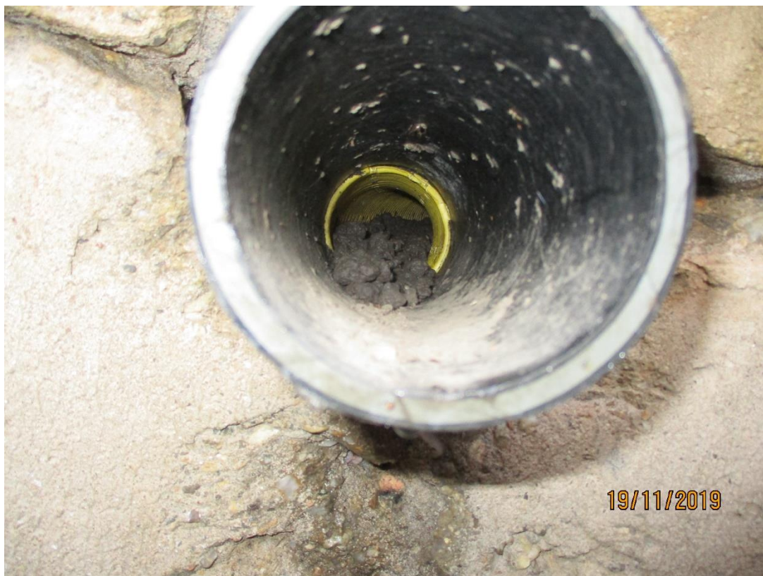
Obr. 31 šachta Š5 stoky H3-1-1, pohled do částečně zanesené přítokové trubky (plast)
