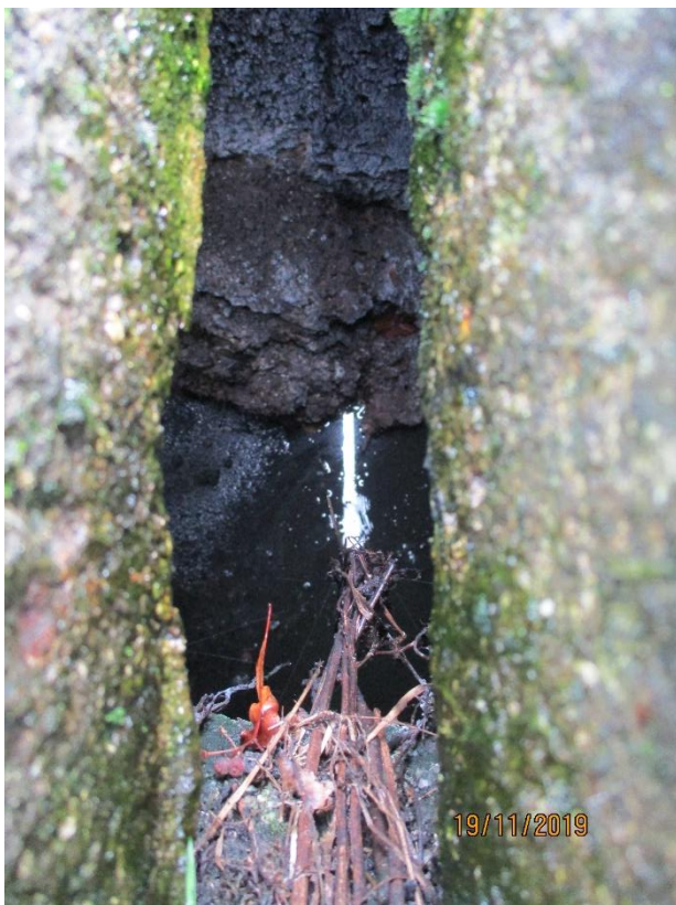
Obr. 14 objekt Š2 (septik) stoky H3 se zákrytovými betonovými panely - pohled dovnitř, hl. 2,05 m, přítok DN300 beton, odtok DN300 beton
