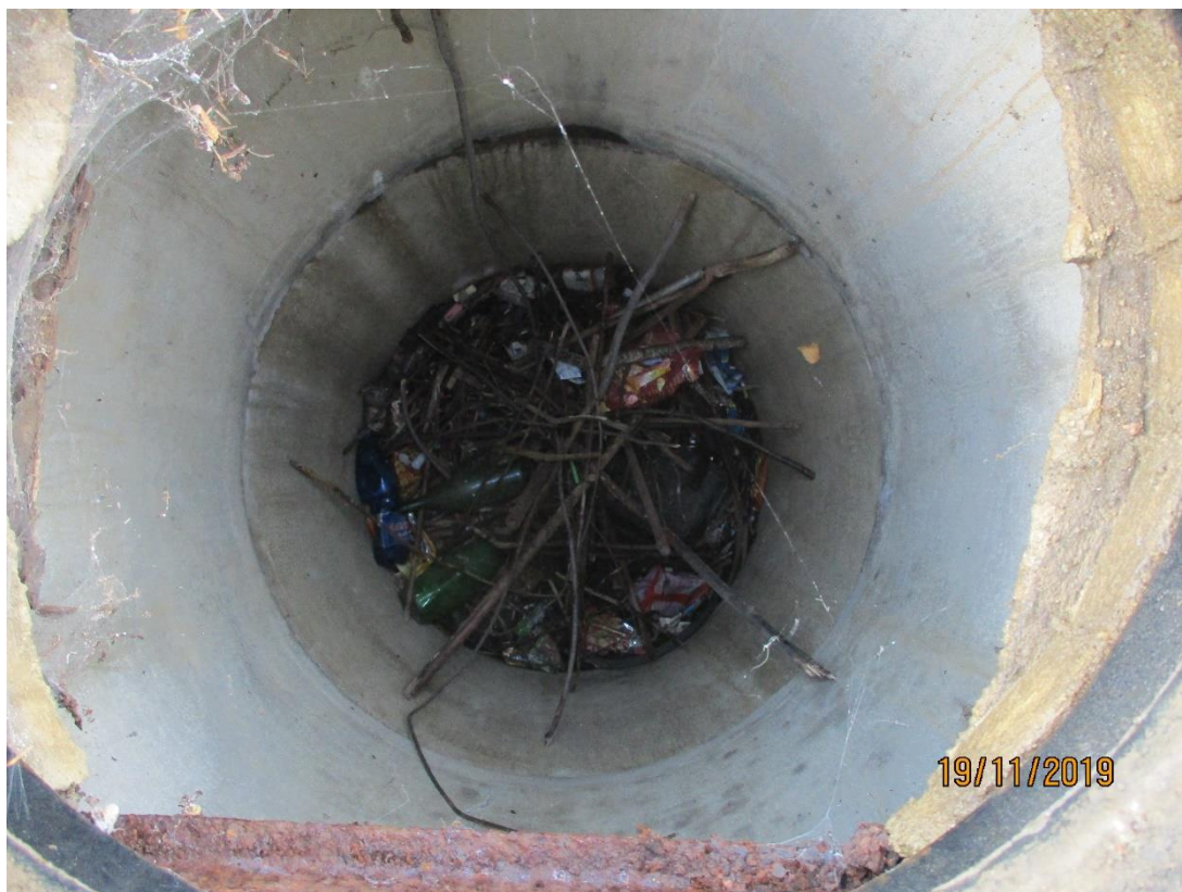
Obr. 33 šachta u budovy na p.č. 132, neznámý účel, zanesená, neznámé DN, neznámé dno
