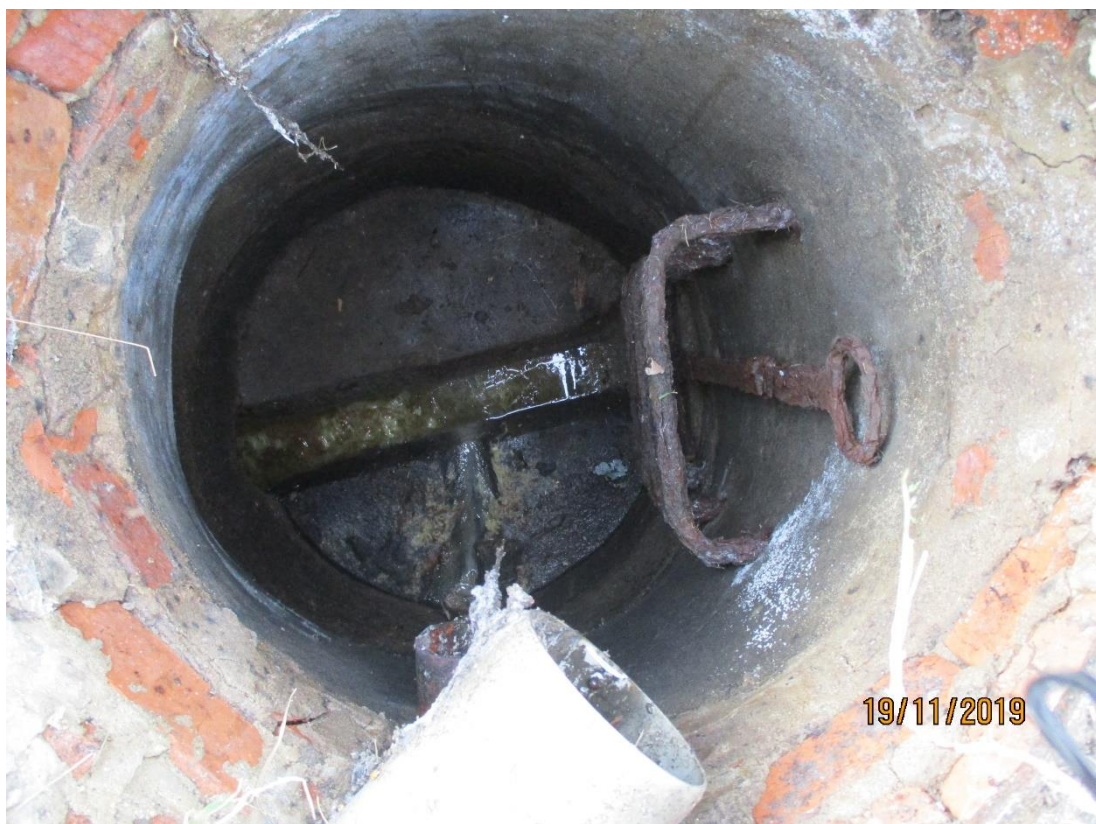
Obr. 24 šachta Š3 stoky H3-1, splašková (jednotná) se stavítkem na výtoku, hl. 2,04 m, přítok DN300 beton, DN200 ocel, DN200 plast, odtok DN300 beton
