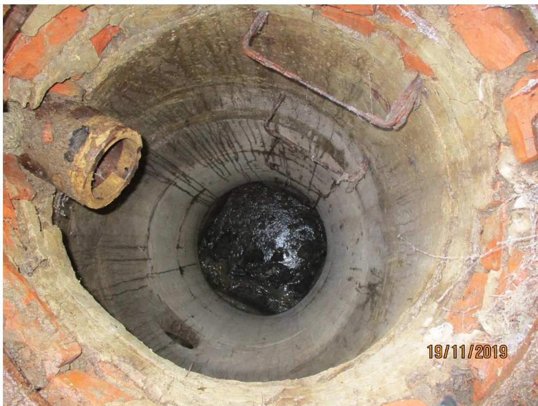
Obr. 20 šachta Š10 stoky H3, splašková (jednotná), stupadla zrezivělá, místy chybějící, hl. 3,50 m, přítok DN500 beton, DN200 beton, DN200 kamenina, odtok DN500 beton
