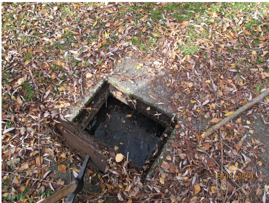
Obr. 26 jímka stavby vedle volejbalového hřiště (stoka H3-1-1), zcela naplněná
