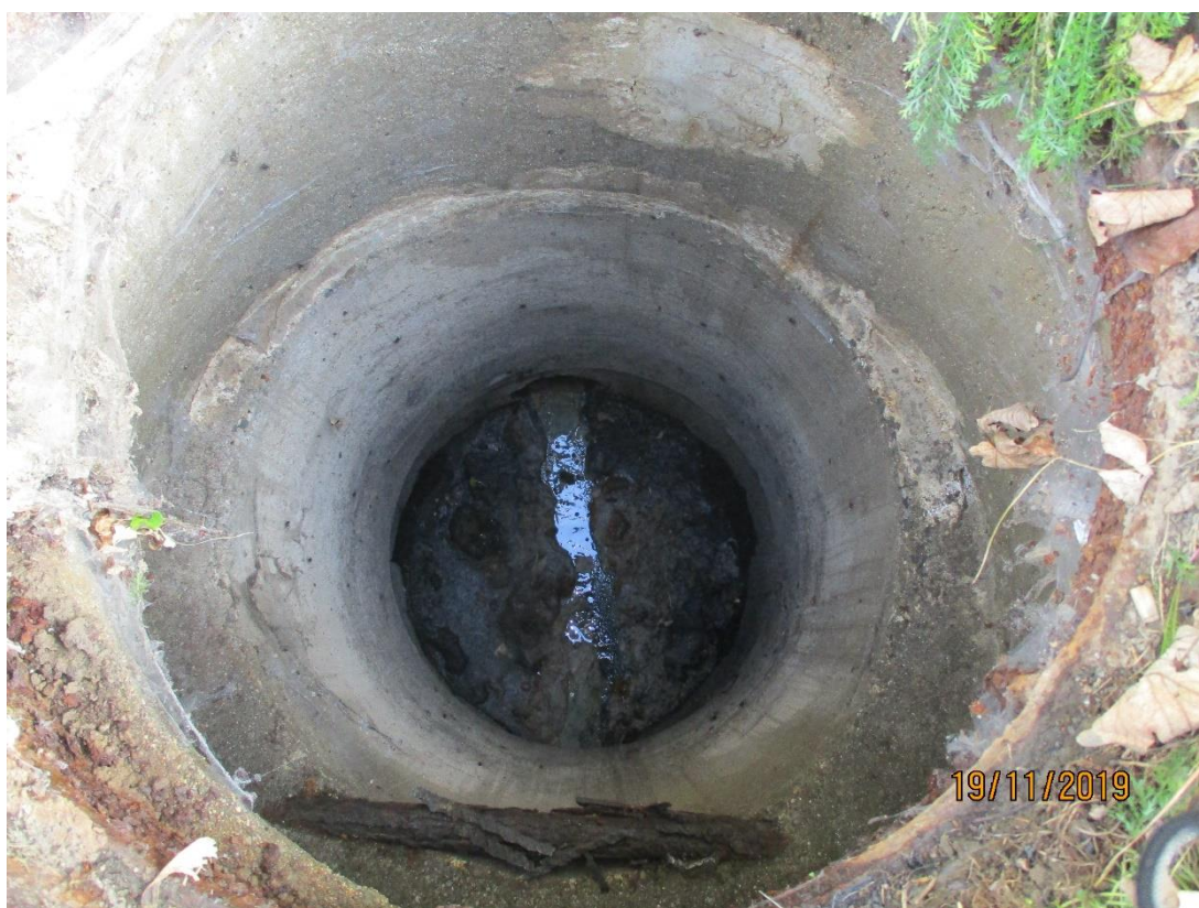
Obr. 34 šachta Š1 stoky H3-2, splašková (jednotná), chybějící stupadla, hl. 2,69 m, přítok DN300 kamenina, odtok DN300 kamenina
