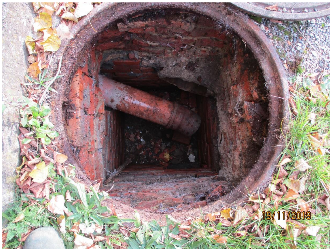
Obr. 7 šachta Š1 stoky H1-1, pravděpodobně jednotná u zámku č.p. 22, hl. 1,59 m, přítok DN300 beton/keramika, DN200 plast, odtok DN300 beton
