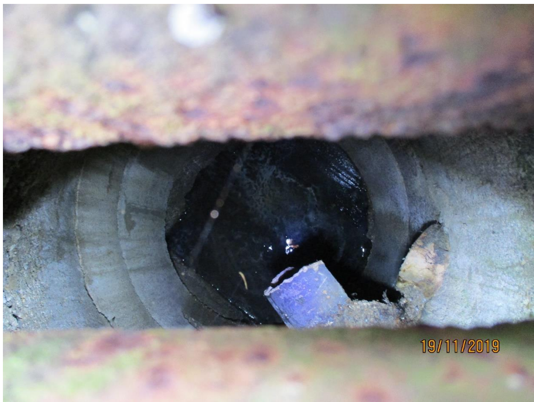
Obr. 5 šachta Š6 stoky H, splašková (jednotná) na dvoře domu č.p. 15, poklop nešel otevřít, hl., 2,62 m, přítok DN400 beton, DN200 kamenina, DN200 plast, odtok DN400 beton
