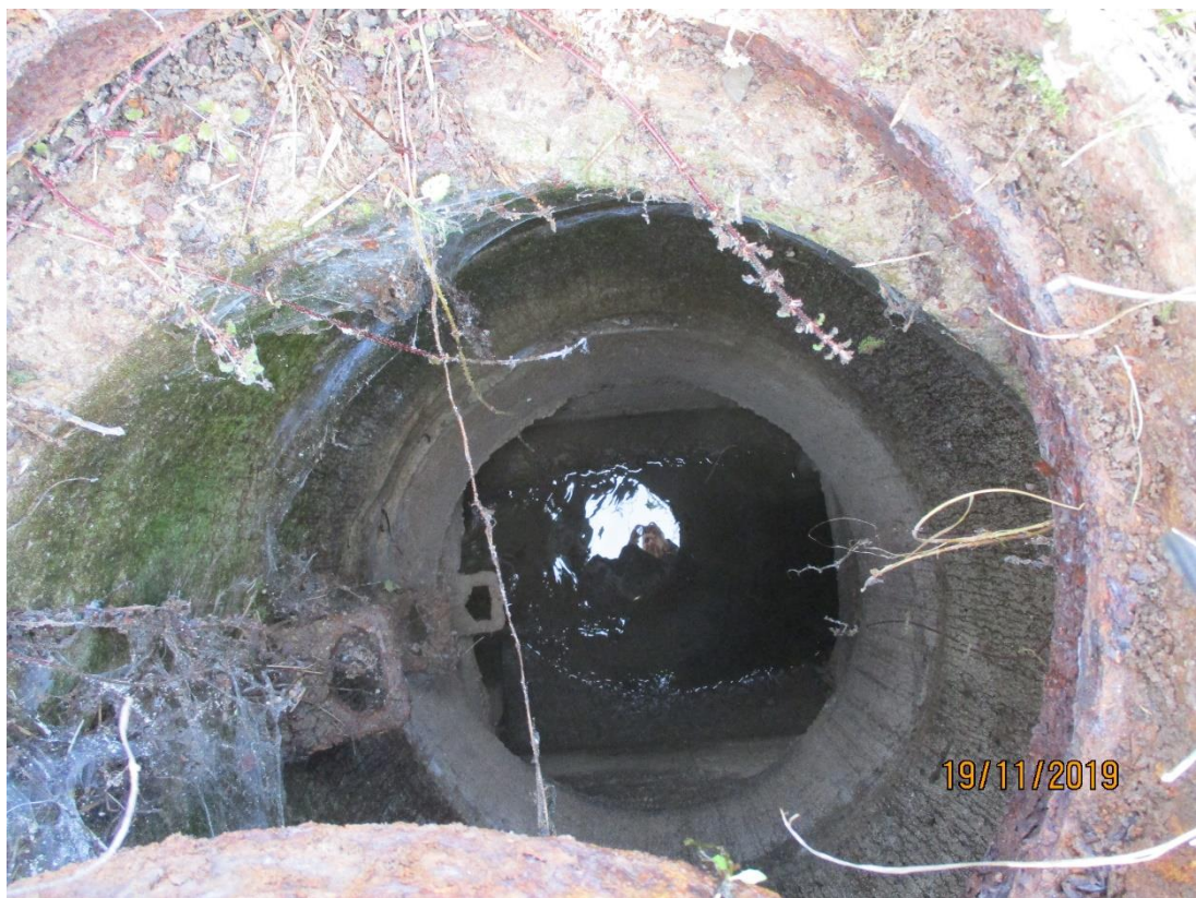
Obr. 1 šachta Š1 stoky H, splašková (jednotná) na okraji zahrady domu č.p. 9, hl. 2,87 m, přítok DN800 beton, odtok DN800 beton
