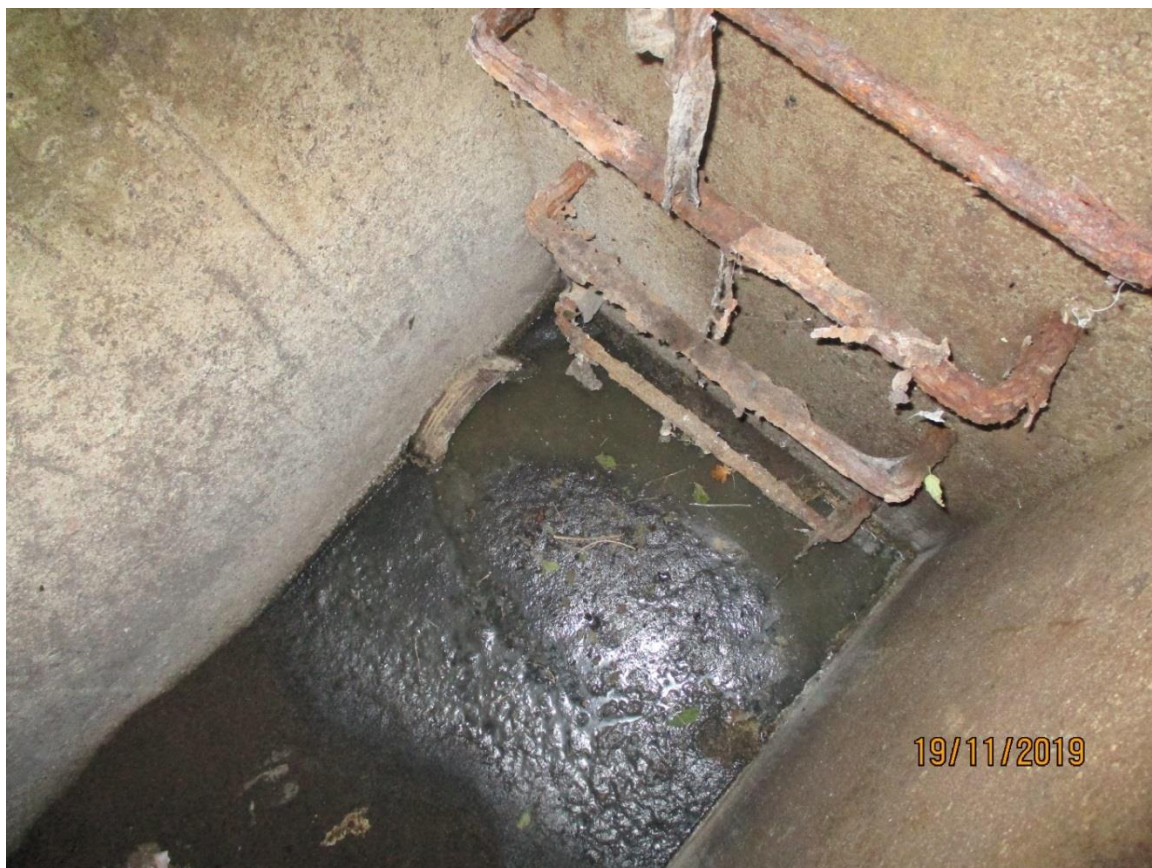
Obr. 15 šachta Š3 stoky H3, splašková (jednotná), hl. 2,06 m, přítok DN300 beton, DN200, odtok DN300 beton
