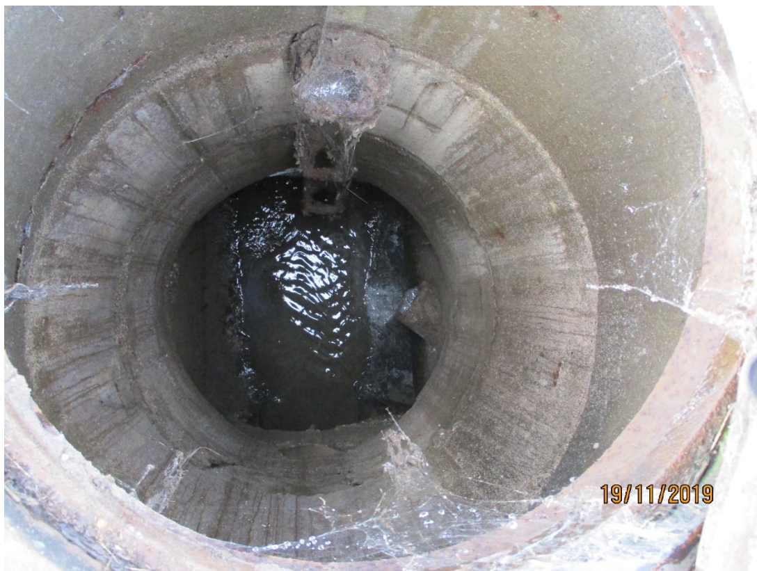
Obr. 3 šachta Š3 stoky H, splašková (jednotná) u domu č.p. 8, hl. 2,78 m, přítok DN800 beton. DN200 beton, odtok DN800 beton
