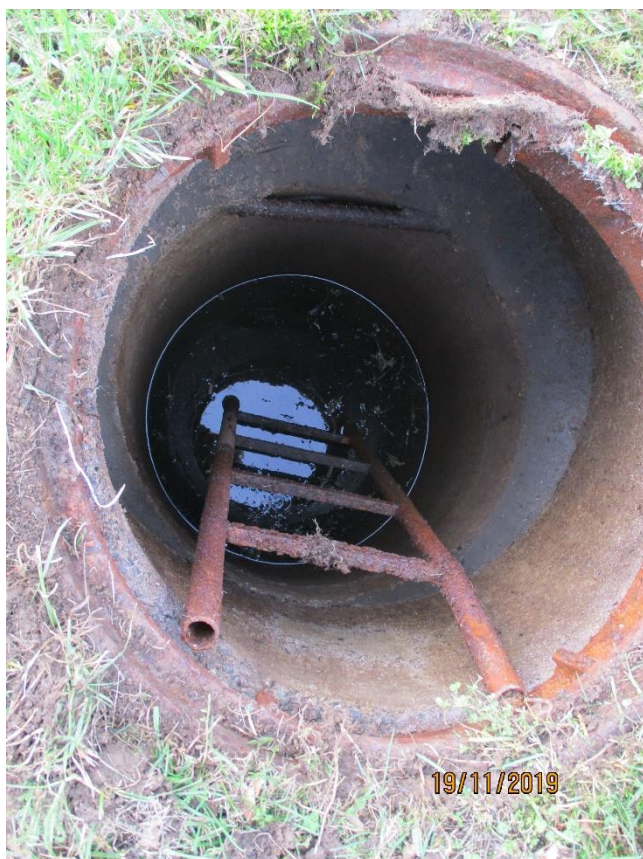
Obr. 27 šachta Š2 stoky H3-1-1, splašková (jednotná) u volejbalového hřiště, částečně chybějící žebřík, hl. 2,35 m, přítok DN300 beton, odtok DN300 beton
