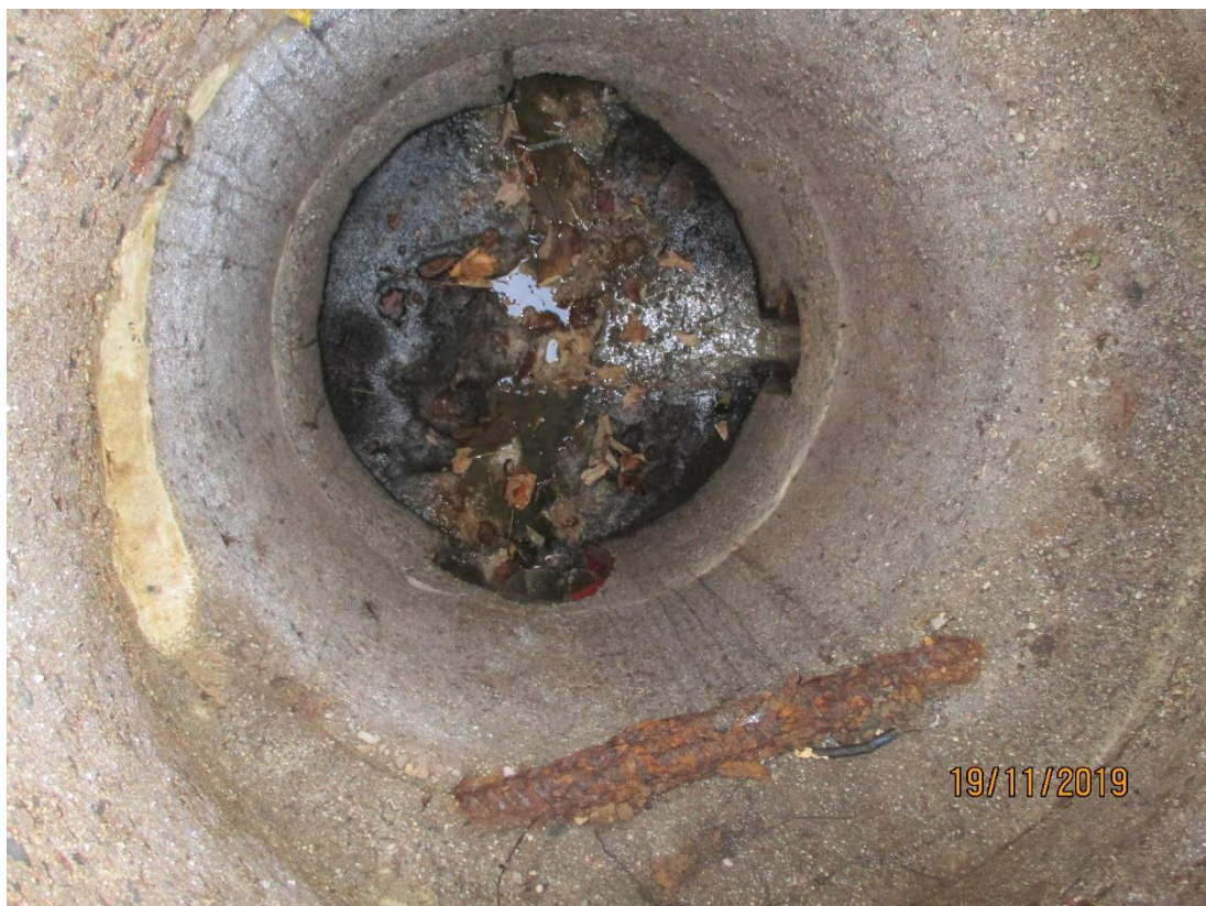
Obr. 35 šachta Š2 stoky H3-2, splašková (jednotná), chybějící stupadla, hl. 1,74 m, přítok DN400 kamenina, DN200 kamenina, odtok DN300 kamenina
