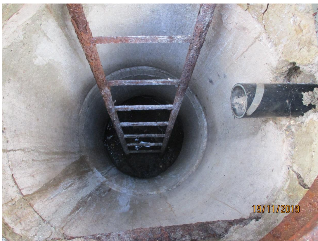
Obr. 30 šachta Š5 stoky H3-1-1, splašková (jednotná), hl. 2,73 m, přítok 2xDN300 beton, DN150 plast, odtok DN300 beton
