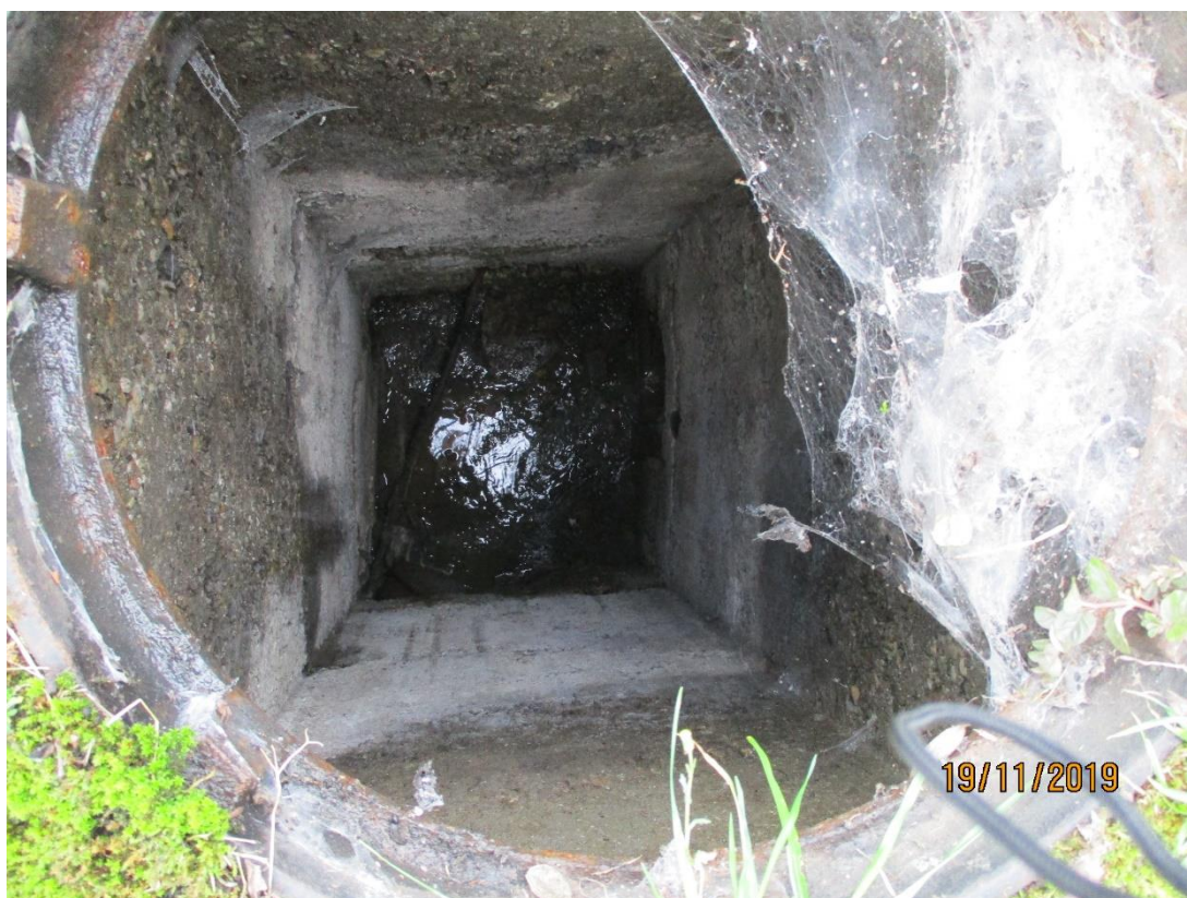
Obr. 16 šachta Š4 stoky H3, splašková (jednotná), hl. 2,64 m, přítok DN300 beton, odtok DN300 beton
