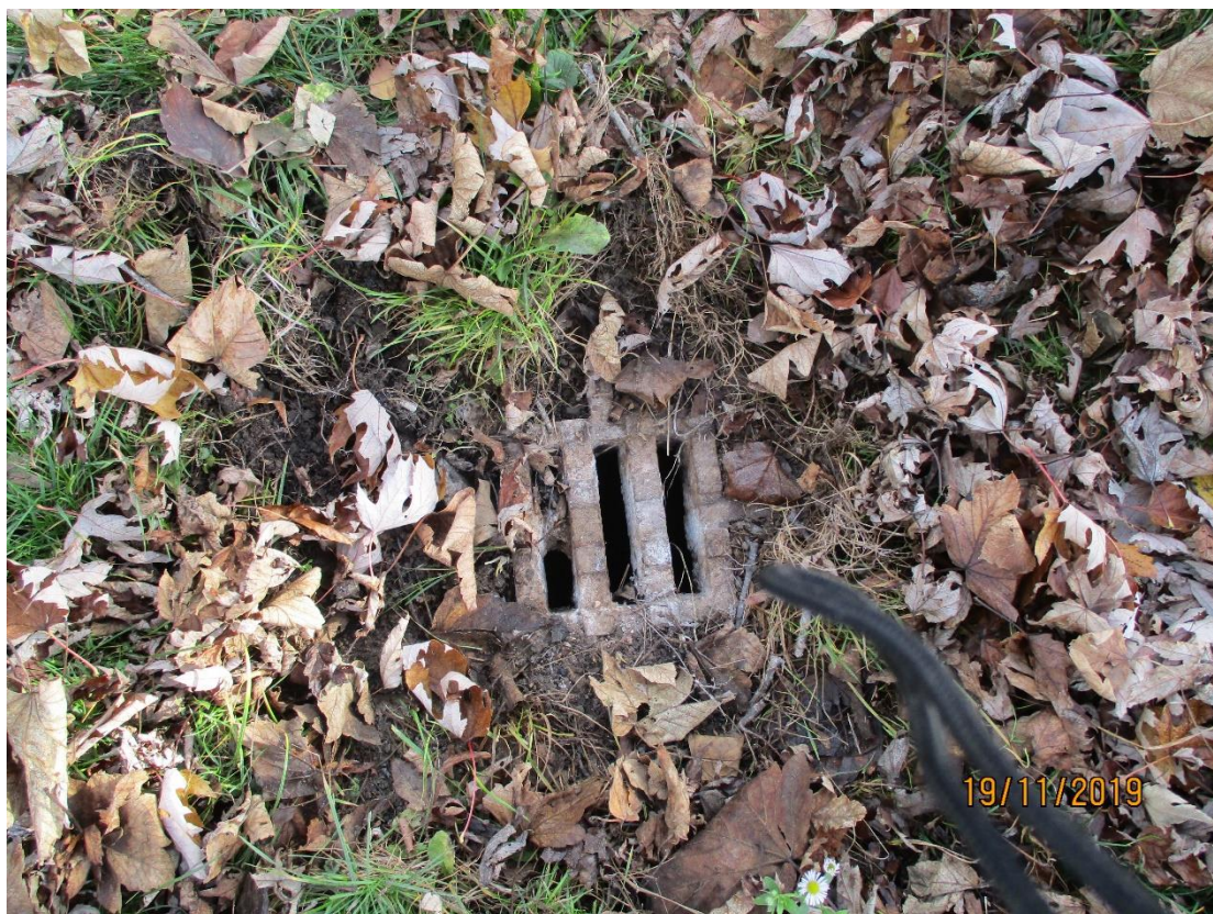
Obr. 37 šachta Š1 stoky H3-3, - pravděpodobně jednotná, poklop nešel otevřít, hl. 1,00 m, přítok DN200, odtok DN200 beton
