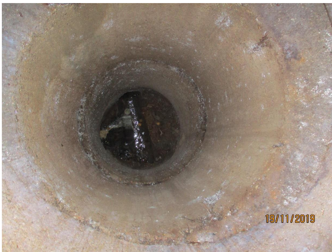
Obr. 18 šachta Š8 stoky H3, splašková (jednotná), chybějící stupadla, hl. 3,02 m, přítok DN500 beton, DN300 kamenina, odtok DN500 beton
