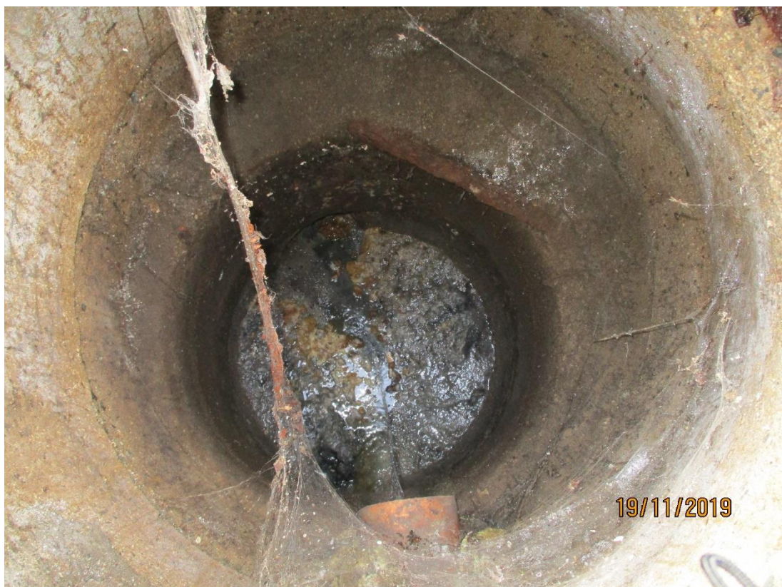
Obr. 36 šachta Š3 stoky H3-2, splašková (jednotná), chybějící stupadla, hl. 1,95 m, přítok DN200 plast, odtok DN400 kamenina
