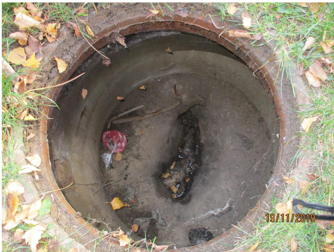
Obr. 21 šachta Š11 stoky H3, splašková (jednotná), hl. 1,27 m, přítok DN200 beton, odtok DN200 beton
