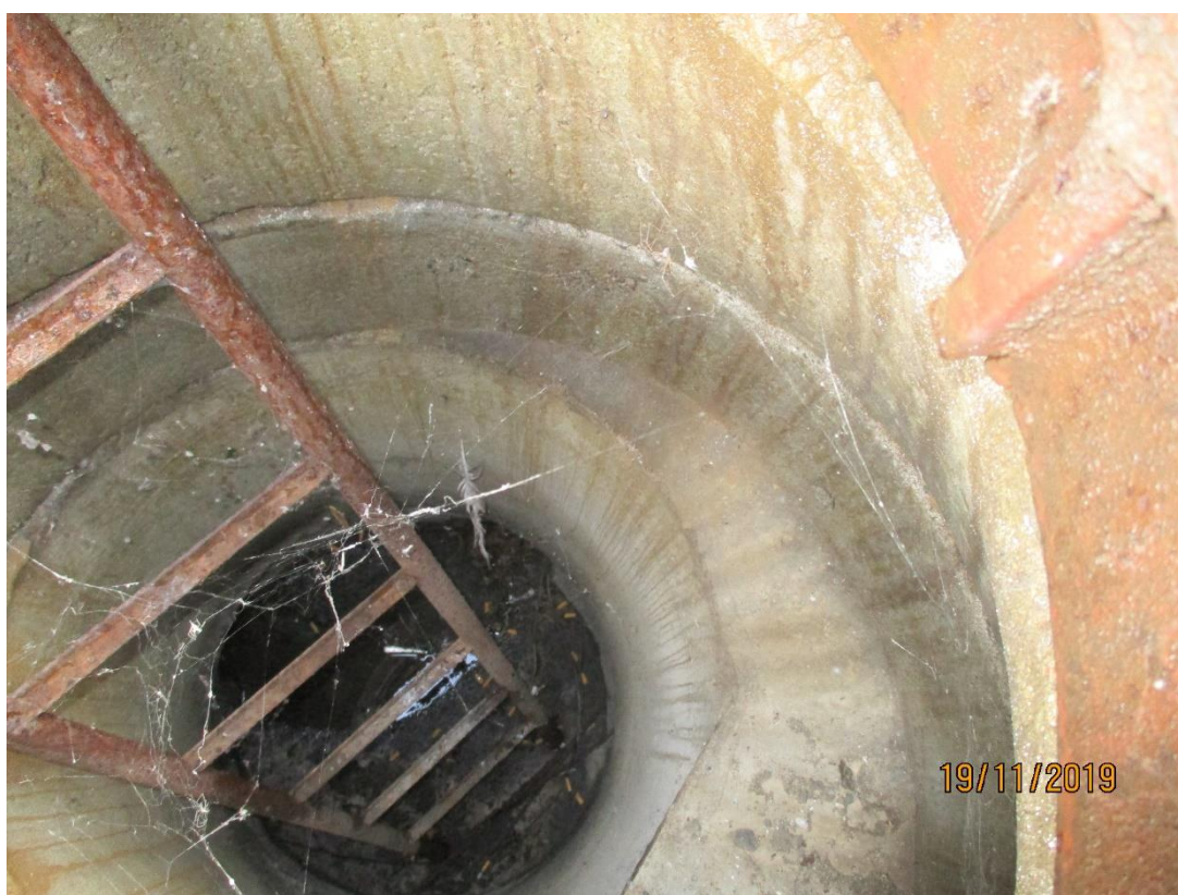
Obr. 32 šachta Š6 stoky H3-1-1, pravděpodobně splašková (jednotná), hl. 2,53 m, přítok DN300 (pravděpodobně), odtok DN300 beton
