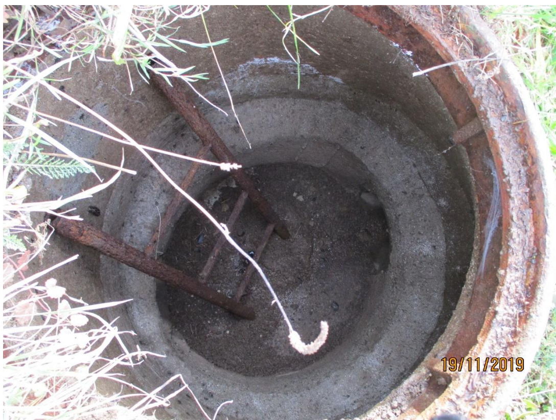
Obr. 22 šachta Š1 stoky H3-1, splašková (jednotná), hl. 1,38 m, přítok 2x DN300 beton, odtok DN300 beton
