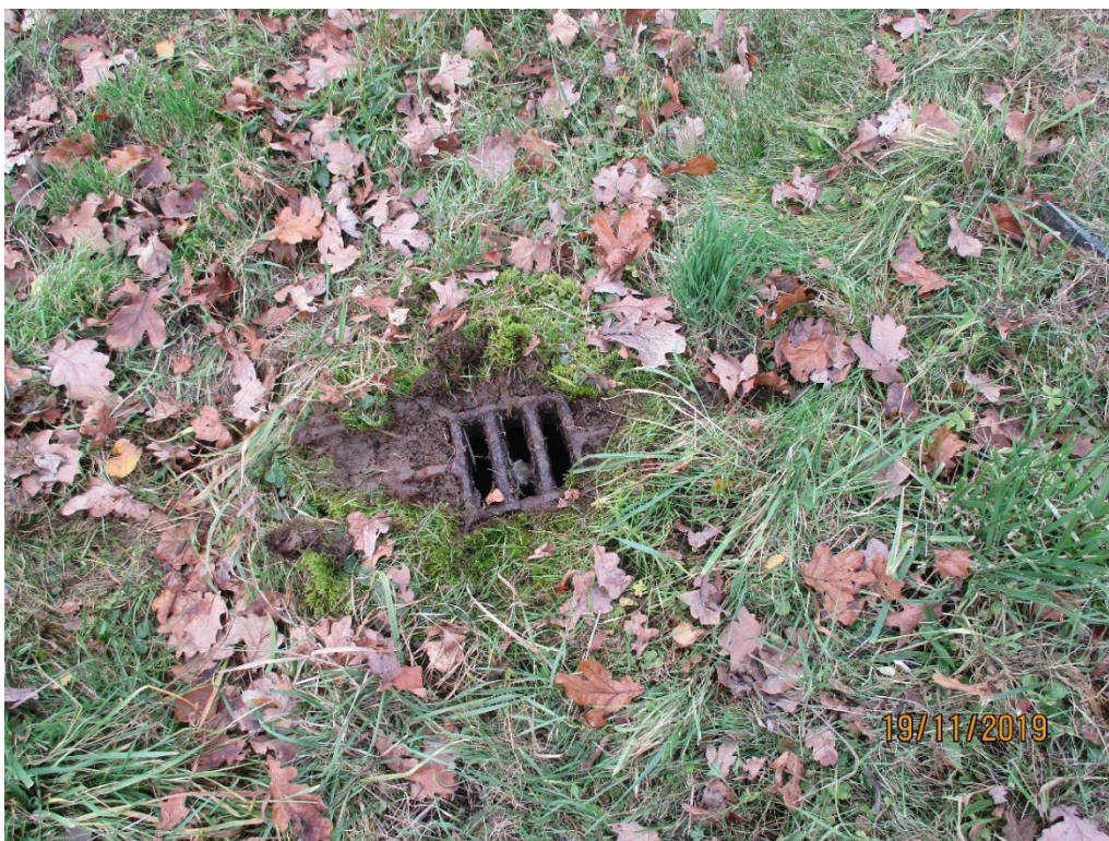
Obr. 13 šachta Š1 stoky H3, pravděpodobně splašková (jednotná) u silnice II/464, poklop nešel otevřít, hl. 3,42 m, přítok 2x DN300 beton, odtok DN300
