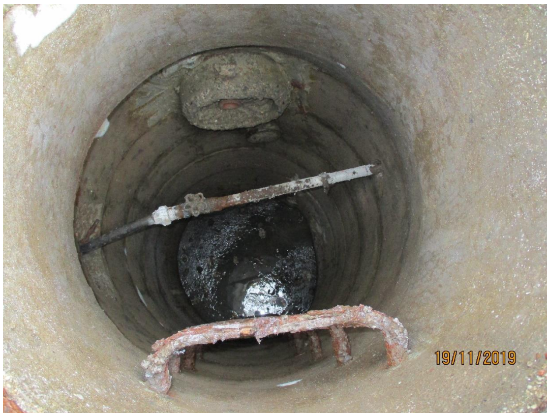
Obr. 17 šachta Š5 stoka H3, splašková (jednotná) domu č.p. 27. hl. 3,02 m, přítok 2x DN300 beton, DN100 kamenina, odtok DN300 beton
