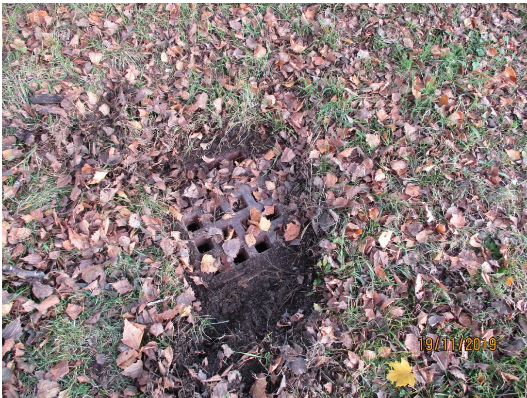
Obr. 11 šachta Š4 stoky H1-1, pravděpodobně dešťová vpust, poklop nešel otevřít, hl. 0,74 m
