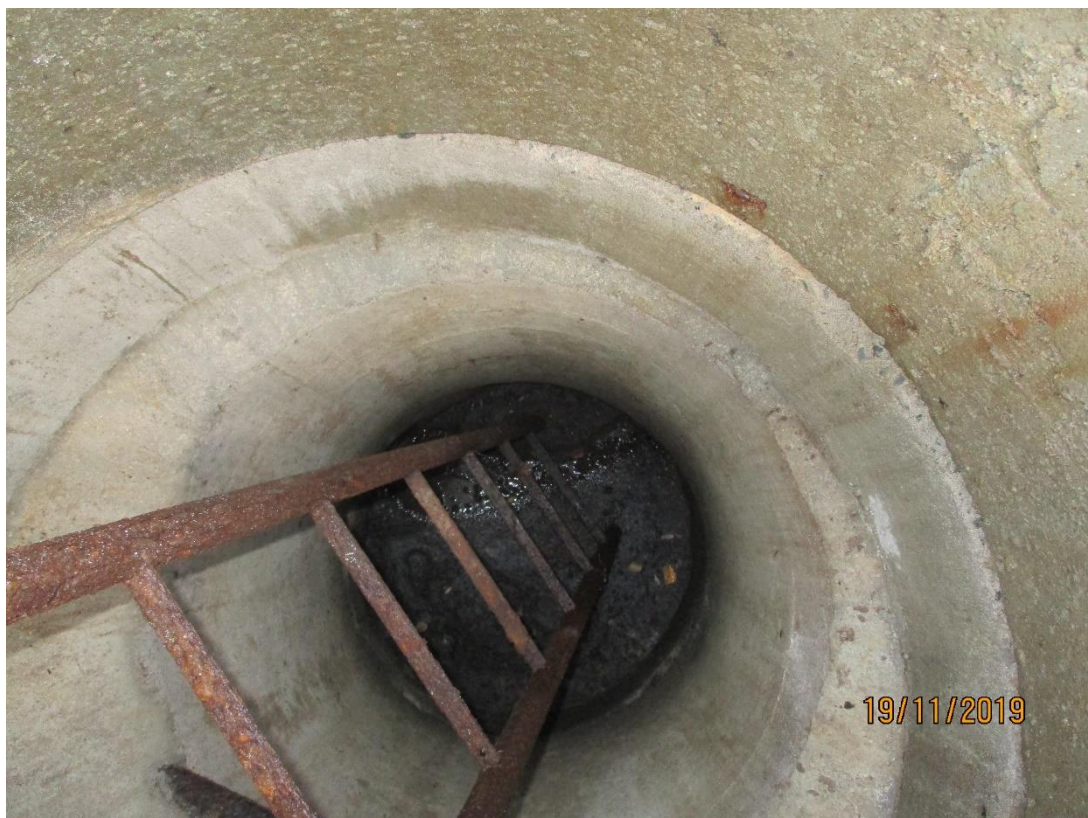
Obr. 29 šachta Š4 stoky H3-1-1, splašková (jednotná), hl. 2,17 m, přítok DN300 beton, odtok DN300 beton
