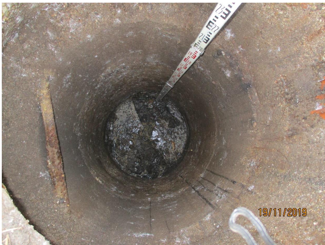
Obr. 38 šachta Š2 stoky H3-3, splašková (jednotná), chybějící stupadla, hl. 2,22 m, odtok DN200 beton
