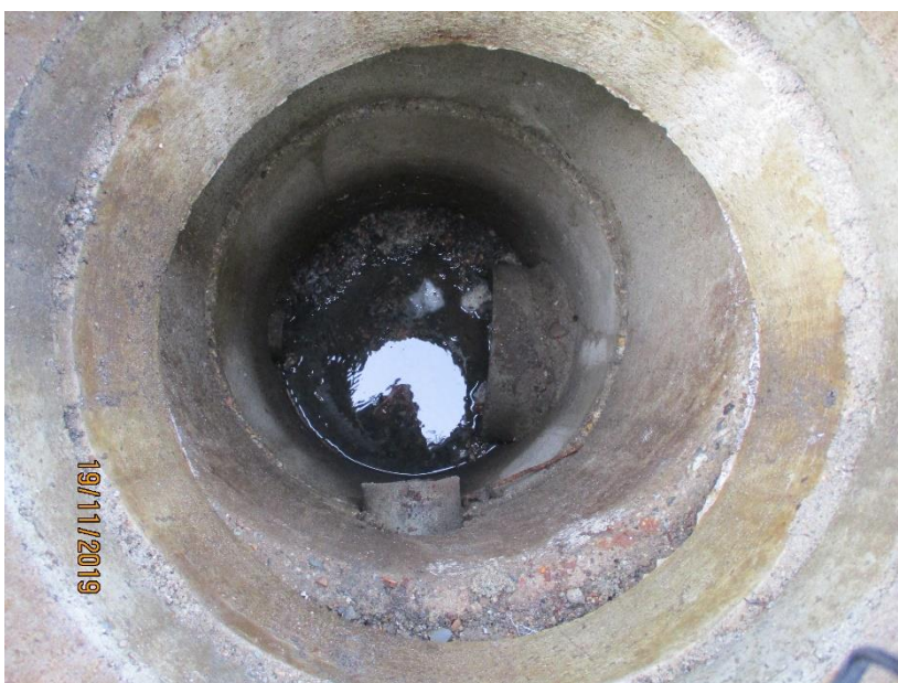
Obr. 12 šachta Š1 stoky H2, splašková (jednotná) u autobusové zastávky, hl. 1,96 m, přítok DN200 beton, odtok DN500 beton
