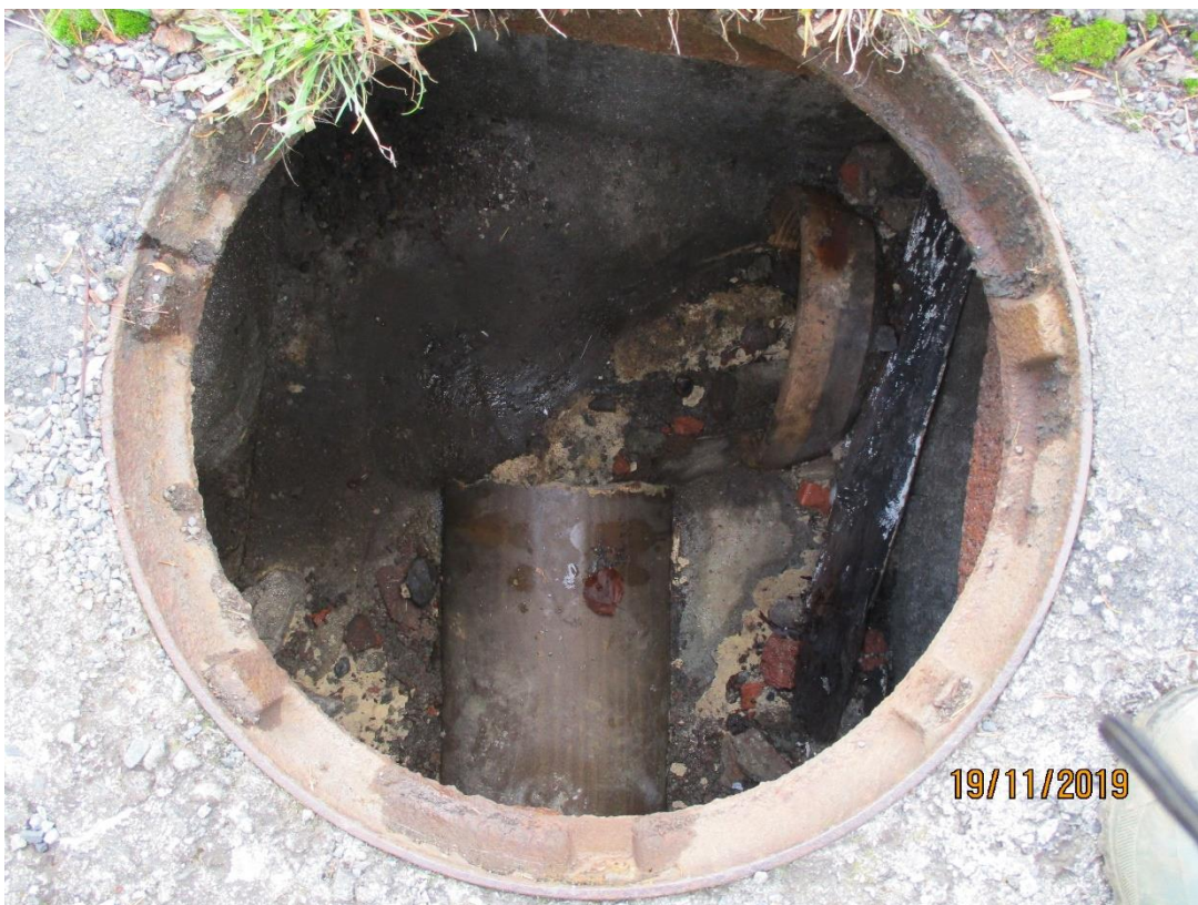
Obr. 10 šachta Š3 stoky H1-1, pravděpodobně jednotná u vjezdu do zámku č.p. 22 (na druhé straně, naproti přes cestu se nachází plastika), hl. 1,06 m, přítok DN300 keramika, odtok DN300 keramika
