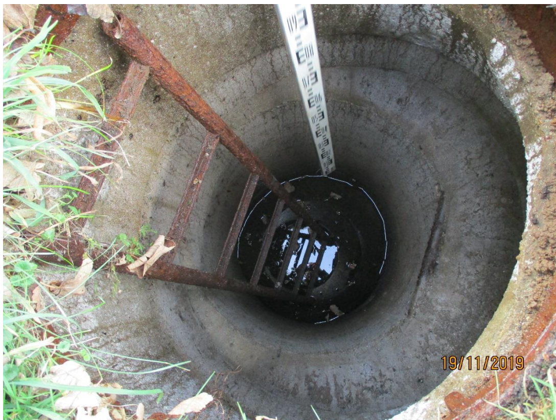
Obr. 28 šachta Š3 stoky H3-1-1, splašková (jednotná), hl. 2,27 m, přítok DN300 beton, odtok DN300 beton
