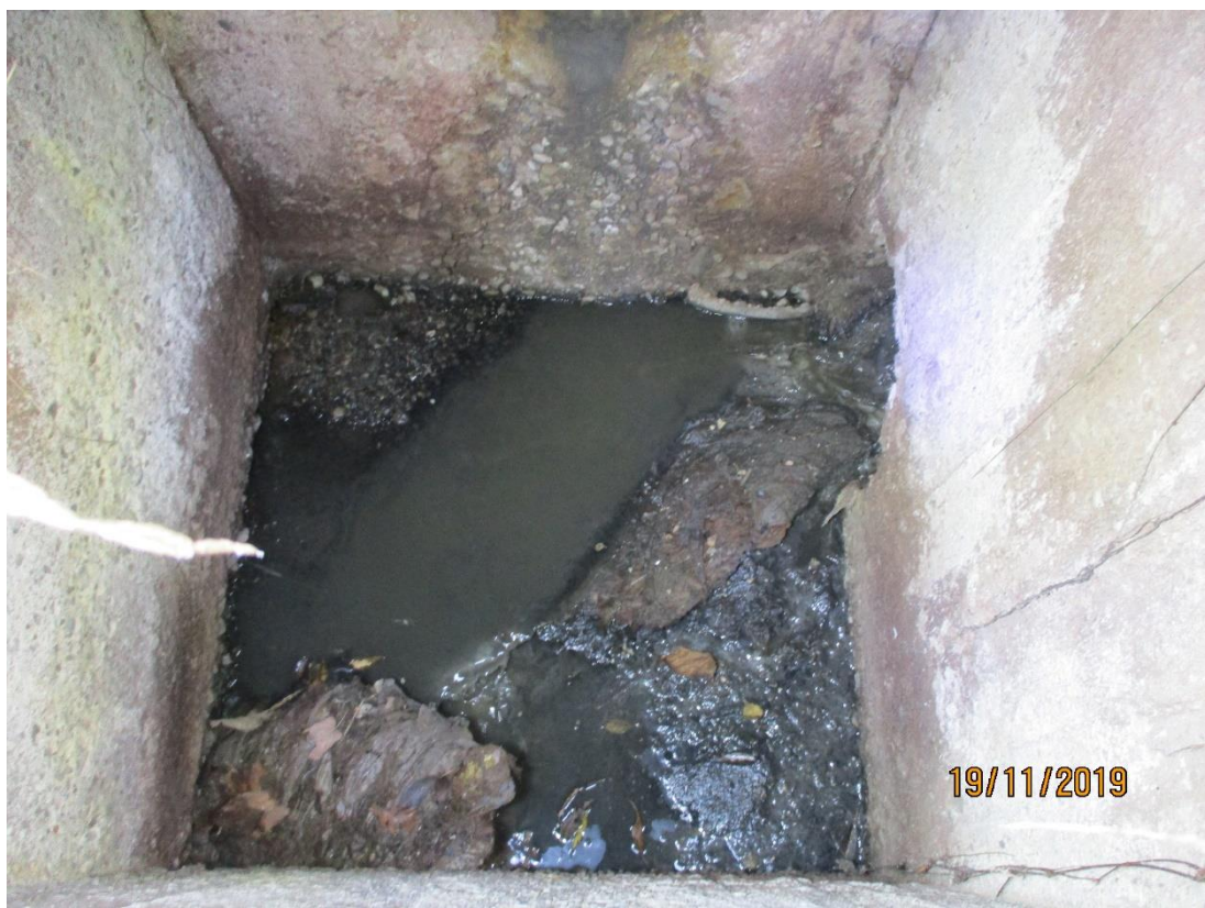
Obr. 6 objekt Š8 stoky H, splaškový (jednotný), u vodního toku pod cestou, výtok do toku nenalezen hl. 1,5 m, přítok DN300 beton, odtok DN500 beton
