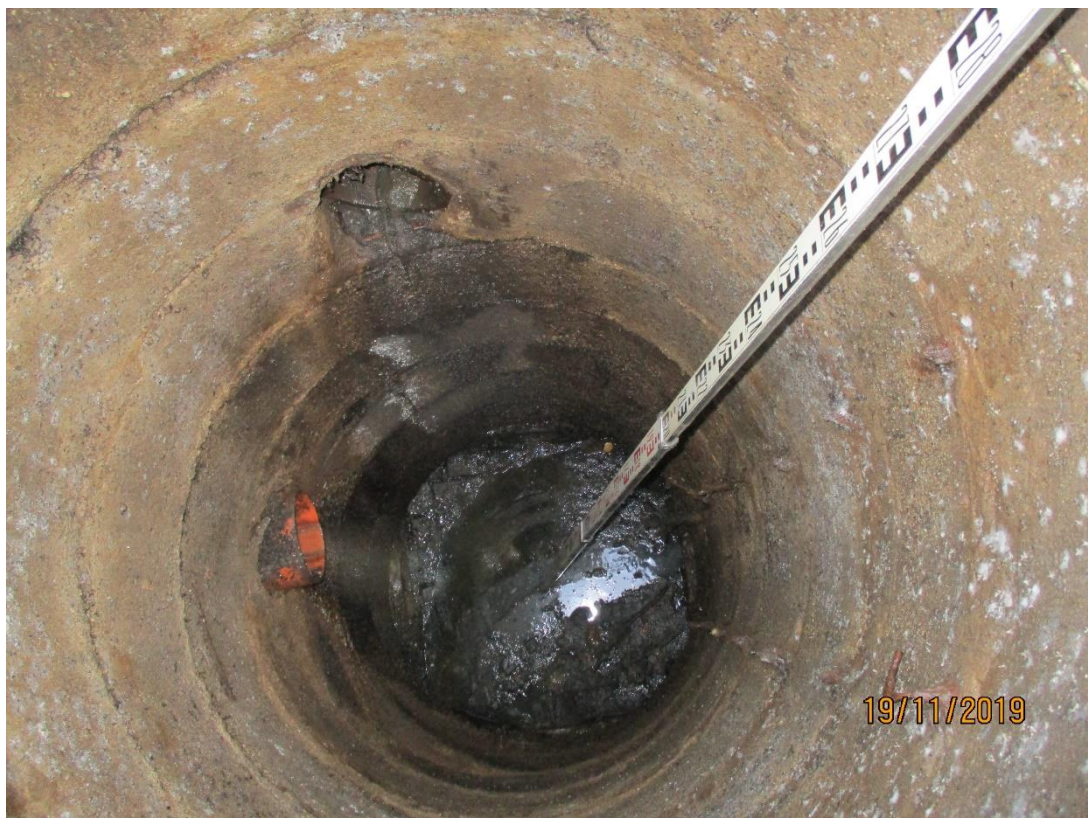
Obr. 19 šachta Š9 stoky H3, splašková (jednotná), chybějící stupadla, hl. 3,29 m, přítok 3x DN 500 beton, DN200 beton, DN200 plast, odtok DN500 beton
