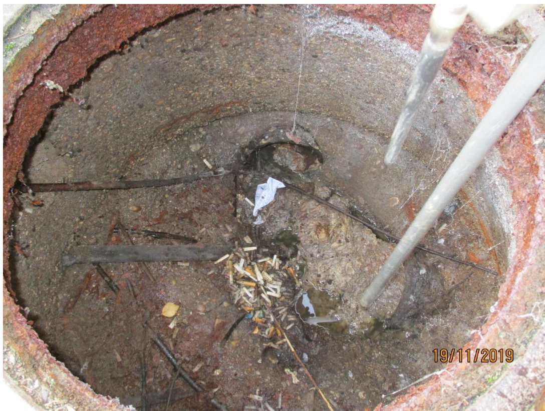
Obr. 39 šachta Š19 stoky H3-4, splašková (jednotná), u vchodu do obytného domu, zanesená, hl. 0,87 m, přítok DN200 beton, odtok DN200 beton
