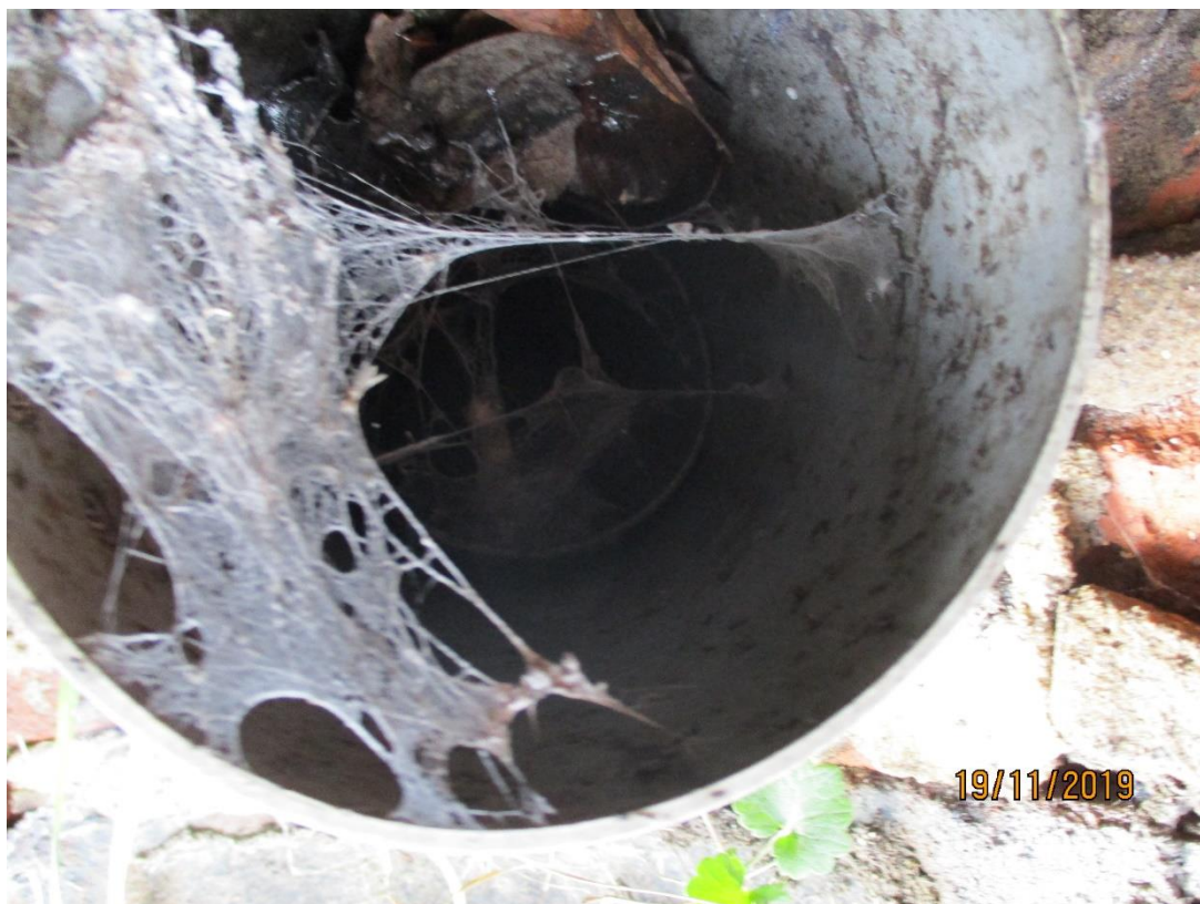
Obr. 25 šachta Š3 stoky H3-1, pohled do plastové přívodní trubky (pravděpodobně dešťové)
