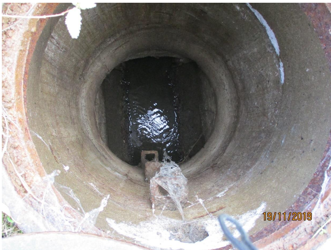
Obr. 4 šachta Š4 stoky H, splašková (jednotná) u domu č.p. 61, hl. 2,68 m, přítok DN800 beton, odtok DN800 beton
