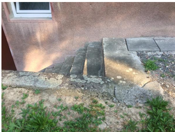
foto č. 6 ukončení zídky, napojení schodů na chodník
