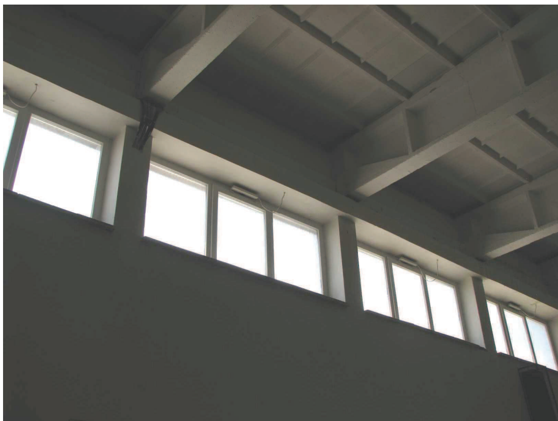
Obr. 4 – Pohled na okna v severovýchodní stěně
