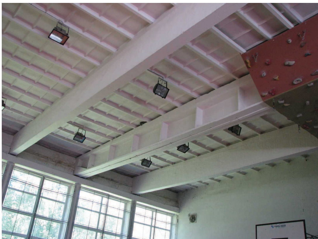
Obr. 1 – Pohled na strop a okna v části jihozápadní stěny.
